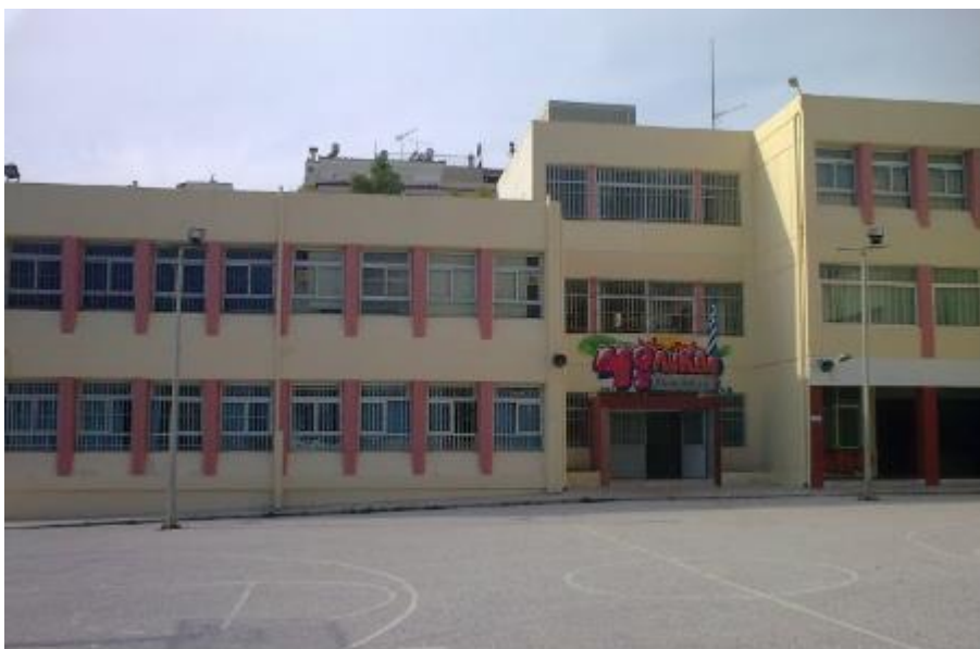
Εικόνα 3.2 Νοτιοδυτική όψη σχολείου, πηγή: http://4gym-ilioup.att.sch.gr/autosch/joomla15/
