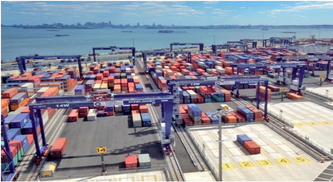
Εικόνα 12 Γερανογέφυρες επί σιδηροτροχιών [Πηγή: KoneCranes, http://www.konecranes.com ]
