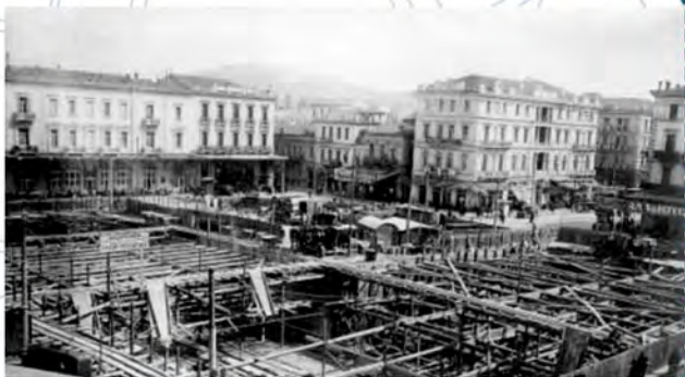
εργοτάξιο διαμόρφωσης πλατείας για τον υπόγειο σταθμό της Ομονοίας | 1930
