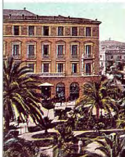
Ξενοδοχείο Μπάγκειον | έργο του αρχιτέκτονα Ερνέστου Τσιλλερ που χτίστηκε την περίοδο 1889-1894 | λειτούργησε για πρώτη φορά το 1894 | σημερινή λειτουργία καταστημάτων στο ισόγειο
