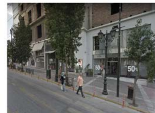
Εμπορική χρήση στο ισόγειο του κτηρίου.
