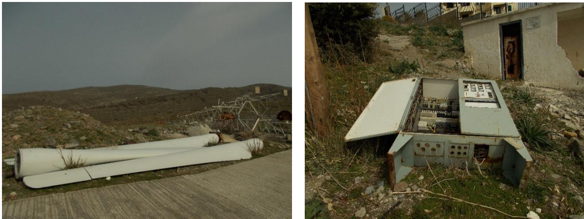
Εικόνα 98. Τμήματα αποκαθλωμένης ανεμογεννήτριας στο λόφο άνωθεν του οικισμού
