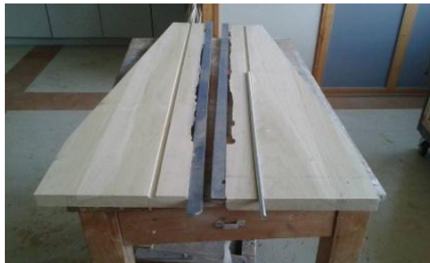
Εικόνα 5.6 :Εσωτερική (επίπεδη) όψη των ολοκληρωμένων τμημάτων της καρίνας όπου φαίνονται οι υποδοχές των δοκών στήριξης και η μία δοκός
