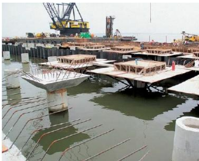
Εικόνα 2-11. Απεικόνιση πασσάλων που στηρίζουν την εξέδρα στο λιμάνι της Βιρτζίνιας (ArcelorMittal, 7/2017)
