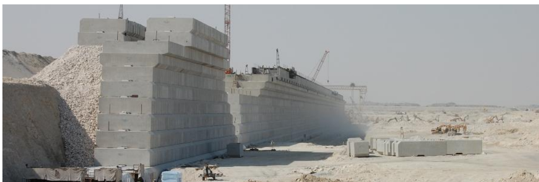
Εικόνα 2-1. Κατασκευή συμπαγούς κλειστού κρηπιδότοιχου για το λιμάνι του Κατάρ ( zabezpieczeniahydrotechniczne.wordpress.com , 6/2017)
