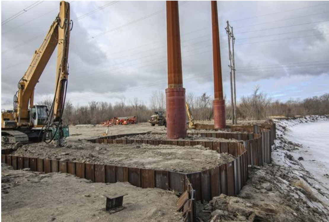
Εικόνα 2-5. Κρηπιδότοιχος από μεταλλικές πασσαλοσανίδες ( www.jfbrennan.com , 7/2017)
