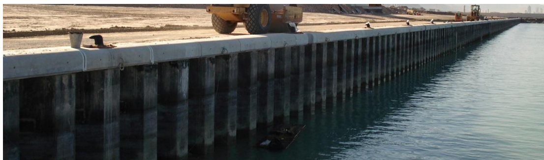
Εικόνα 2-8. Κρηπιδότοιχος από μεταλλικό πασσαλότοιχο ( www.escpile.com , 7/2017)
