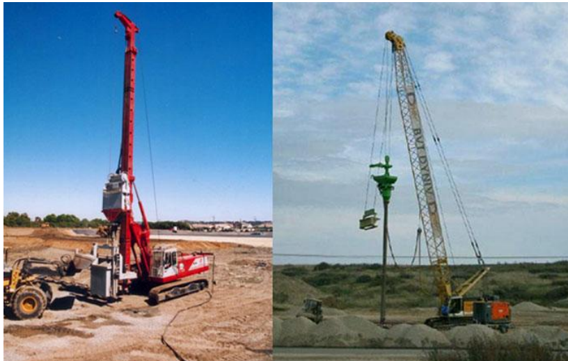
Εικόνα 1-15. Συστήματα ανάρτησης της δονητικής στήλης στη μέθοδο τροφοδοσίας στην αιχμή ( www.zetas.com.tr , 7/2017)
