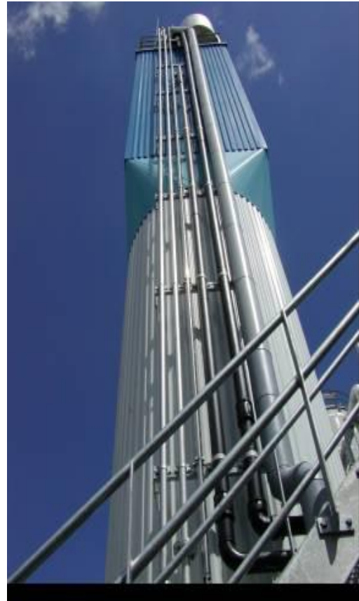
Σχήμα 2.6.:Ο πρώτος ANAMMOX αντιδραστήρας για την επεξεργασία υγρών λυμάτων, της Waterboard Hollandse Delta (WHSB), Rotterdam. (W.R. Abma et al. 2006, Ποθουλάκη 2009).
