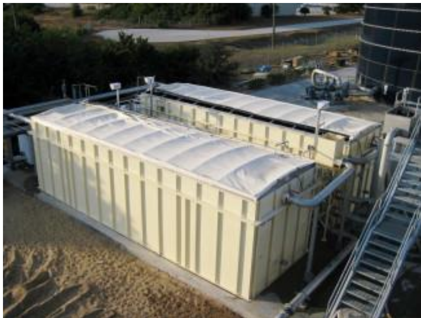
Σχήμα 2.4: Αναερόβιοι βιοαντιδραστήρες μεμβρανών. Προέλευση: http://www.thembrsite.com .
