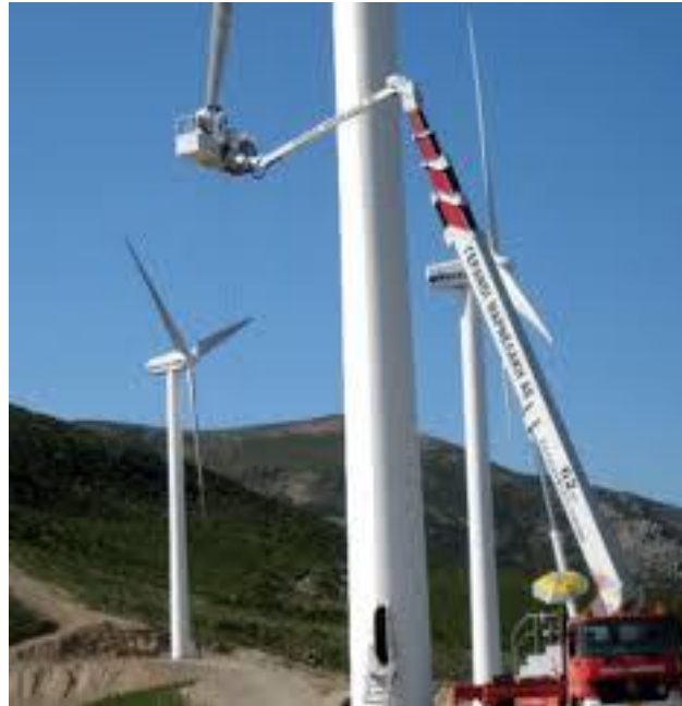
Εργασίες σε ανεμογεννήτριες με ανυψωτικό, http://www.marnelakis.com/ , 28/06/2017
