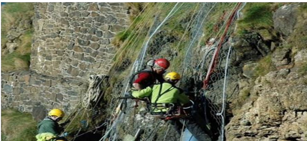
Τοποθέτηση δικτύου προστασίας από λιθοπτώσεις, http://www.strongholdpreservation.com/media/29938/cintec_anchor_rope_access_survey_dunluce_co_antrim_northern_ireland_ni_3.jpg?width=448
