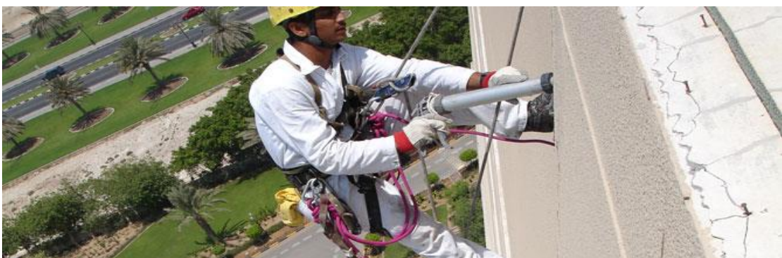
Αποκατάσταση σκυροδέματος, http://www.irata.org/where_rope_access_is_used.php
