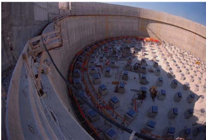
Εικόνα 3.26 : Εγκατάσταση σεισμικών εφεδράνων τριβής στη Ρεβυθούσα, Ελλάδα
