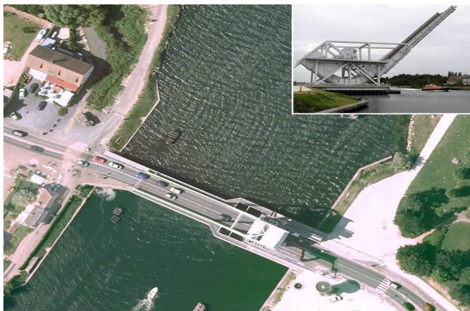
Εικόνα 70: Γέφυρα, Πηγή: google. Image
