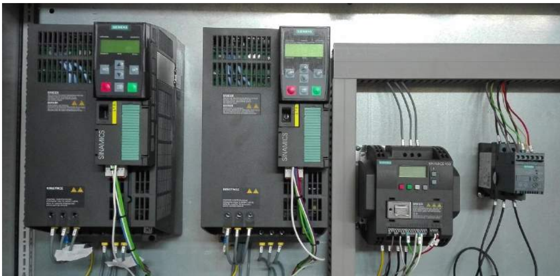
Εικόνα 2.23 Ηλεκτρονικά ισχύος της εγκατάστασης. Από αριστερά προς τα δεξιά: Sinamics G120, Sinamics V20, SIRIUS 3RW30
