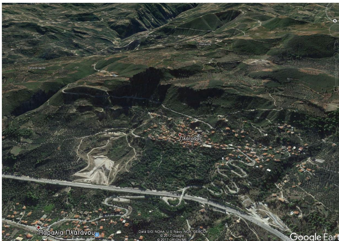
Εικόνα 4.10 Αποψη του οικισμού του Πλατάνου και η εμφανής θέση της κατολίσθησης
