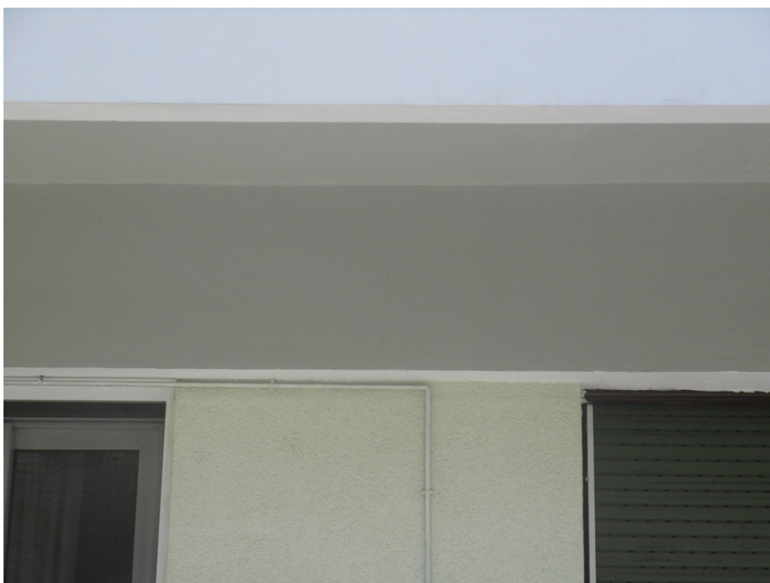
Εικόνα 7.8 Σημείο 3 καμπτική ρωγμή στο μέσο δοκού
