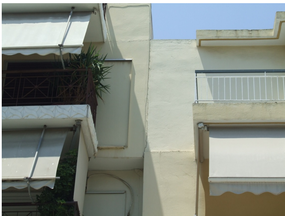
Εικόνα 6.38 Θέση 2, διεύρυνση αντισεισμικού αρμού
