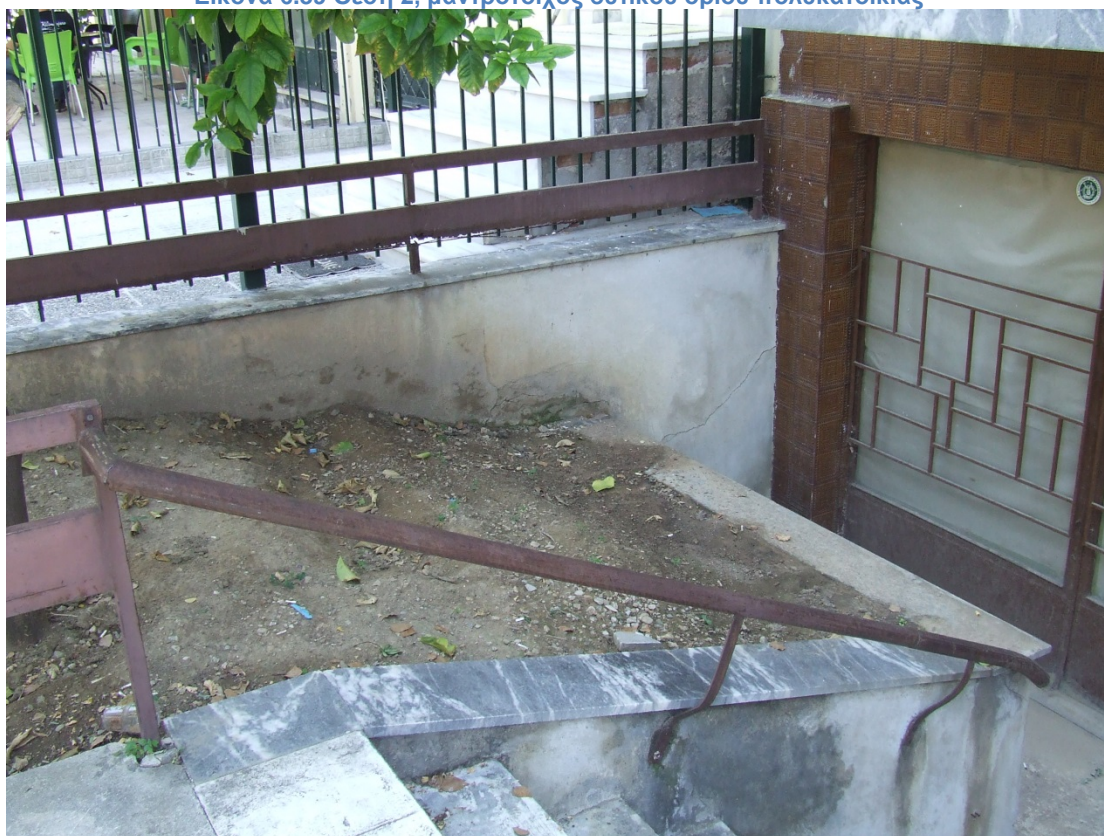
Εικόνα 6.40 Θέση 2, μαντρότοιχος ανατολικού ορίου πολυκατοικίας
