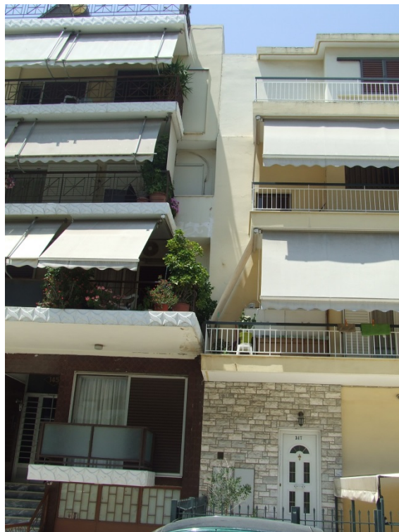
Εικόνα 6.37 Θέση 2, διεύρυνση αντισεισμικού αρμού
