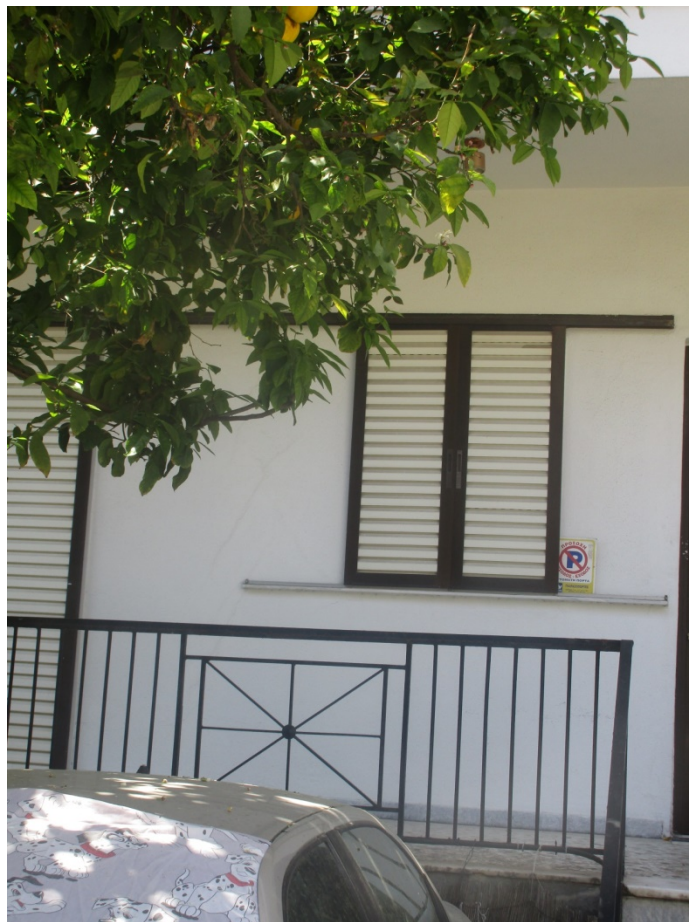
Εικόνα 7.11 Σημείο 4 Χιαστί ρωγμάτωση σε τοιχοποιία
