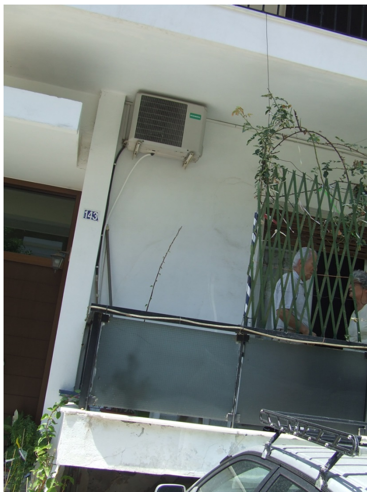
Εικόνα 6.35 Θέση 1, Χιαστί ρωγμάτωση σε τοιχοποιία
