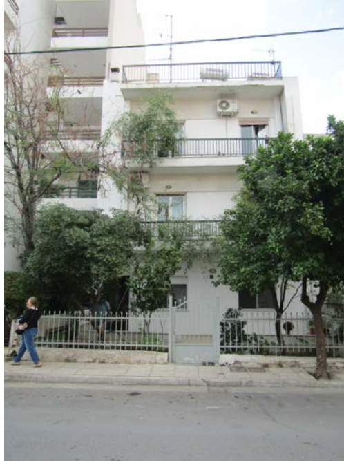
Εικόνα 6.17. Σημείο 1, απόκλιση διωρόφου κτηρίου από την κατακόρυφο
