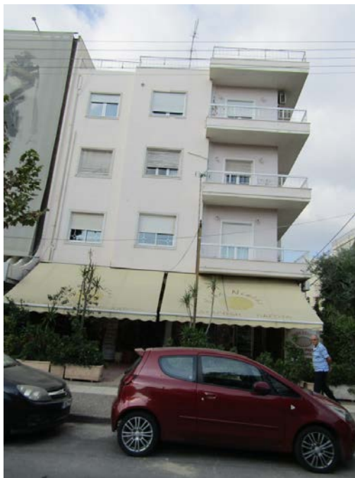
Εικόνα 6.20, Σημείο 1, Γενική άποψη κτηρίου
