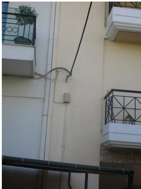
Εικόνα 7.24 Σημείο 2. Χιαστί ρωγμάτωση σε υποστύλωμα.
