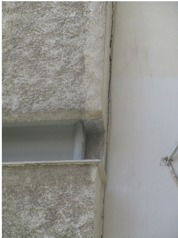
Εικόνα 7.10 Σημείο 3. Διεύρυνση αντισεισμικού αρμού, απόκλιση από την κατακόρυφο
