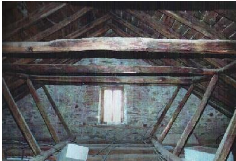
Εικόνα 1.3 Ξύλινη Στέγη Πέτρινης Κατασκευής
