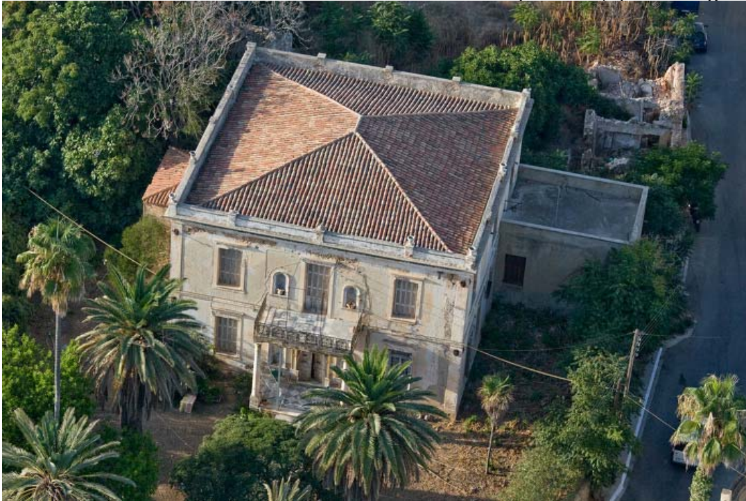
Εικόνα 6.1 Χαρακτηριστική αεροφωτογραφία κτιρίου με τη σημερινή του μορφή
