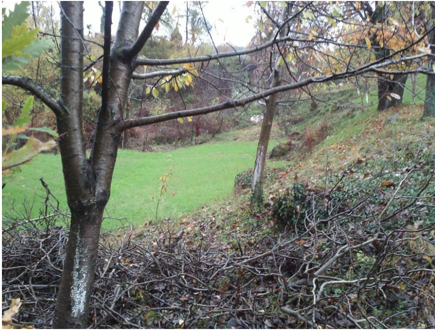
Εικόνα 3.51: Φωτογραφία από περιοχή άνωθεν της εμφανισθείσας κατολίσθησης στη ΧΘ 13+150 (OMIKRON KAPPA Consulting, December 2012)
