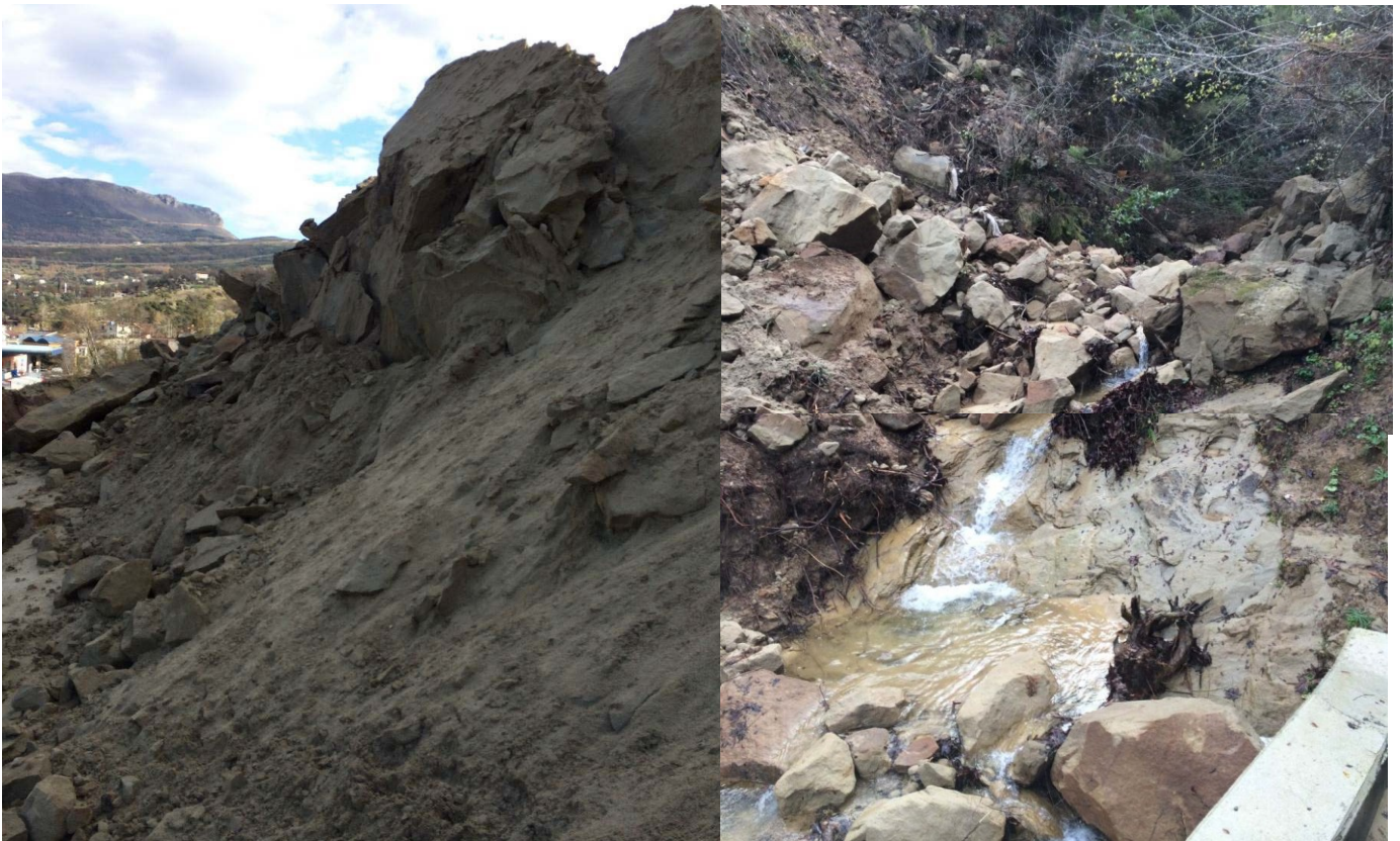
Εικόνα 3.24: Φωτογραφία από σχηματισμό μετά την κατολίσηση (αριστερά) και της ροής νερού στο αποστραγγιστικό παρειανά του πρηνούς ακριβώς μετά την κατολίσηση (δεξιά)
