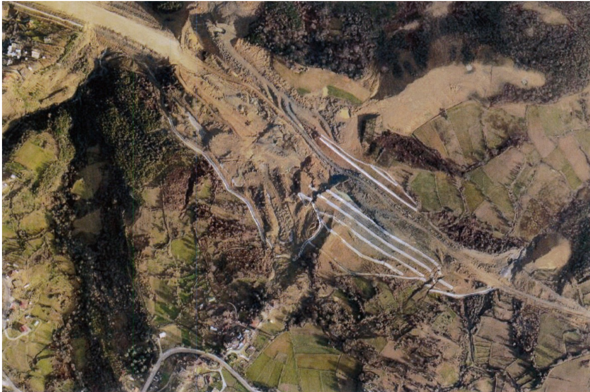
Εικόνα 3.45: Ορθοφωτογραφία από περιοχή κατολίσθησης ΧΘ 13+150 μετά την επανεργοποίηση της τον Δεκέμβριο του 2014
