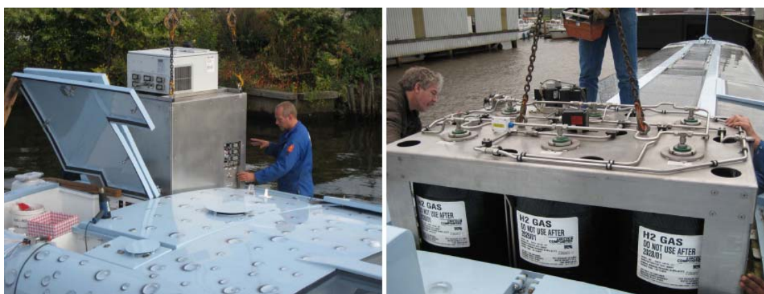
Εικόνα 3.9 Τοποθέτηση συστήματος κυψελών καυσίμου και φιαλών αποθήκευσης υδρογόνου [36].
