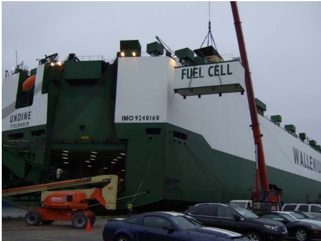
Εικόνα 3.12 Τοποθέτηση του συστήματος κυψελών καυσίμου στο κατάστρωμα του πλοίου [38].
