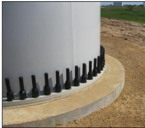
Εικόνα 1.21: Λεπτομέρεια κοχλιωτής σύνδεσης πυλώνα – άνω δακτυλίου
