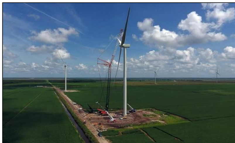
Εικόνα 1.10: Φάση κατασκευής χερσαίας ανεμογεννήτριας
