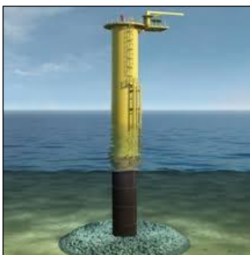
Εικόνα 4.5: Απεικόνιση τυπικής θαλάσσιας ανεμογεννήτριας με θεμελίωση μονοπάσσαλου
