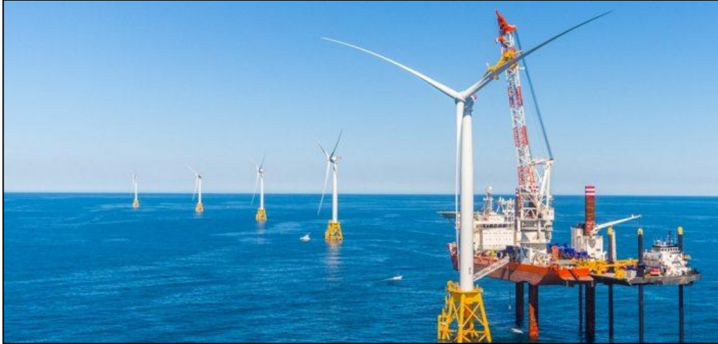
Εικόνα 1.11: Φάση κατασκευής θαλάσσιας ανεμογεννήτριας
