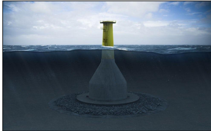
Εικόνα 4.3: Απεικόνιση τυπικής θαλάσσιας ανεμογεννήτριας με θεμελίωση βαρύτητας
