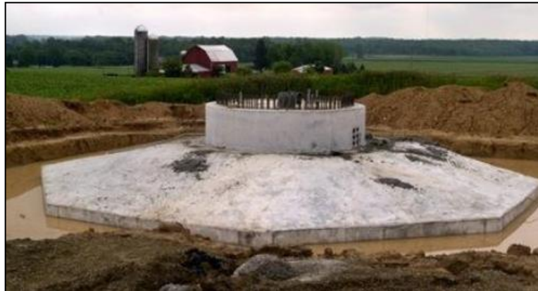
Εικόνα 1.18: Οκταγωνική θεμελίωση βαρύτητας
