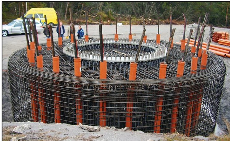
Εικόνα 1.22: Θεμελίωση βαρύτητας με αγκυρώσεις στον υποκείμενο βράχο
