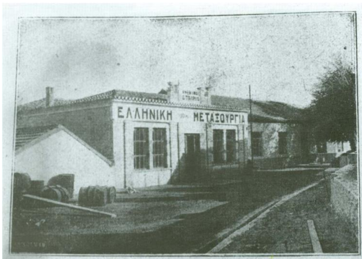
Εικόνα: Το παλαιότερο εργοστάσιο της Μεταξουργίας, τμήμα του κτιρίου γνωστό ως «Γραφεία της Μεταξουργίας». Σήμερα, δεν διασώζεται τίποτα από αυτά. Πηγή: Μαΐστρου Ε., Βογιατζόγλου Ο. Καραθανάση Ε. Καλιοτζίδου Μ. «Η Βιομηχανική κληρονομιά της Νέας Ιωνίας», ΕΤΒΑ, 1985.
