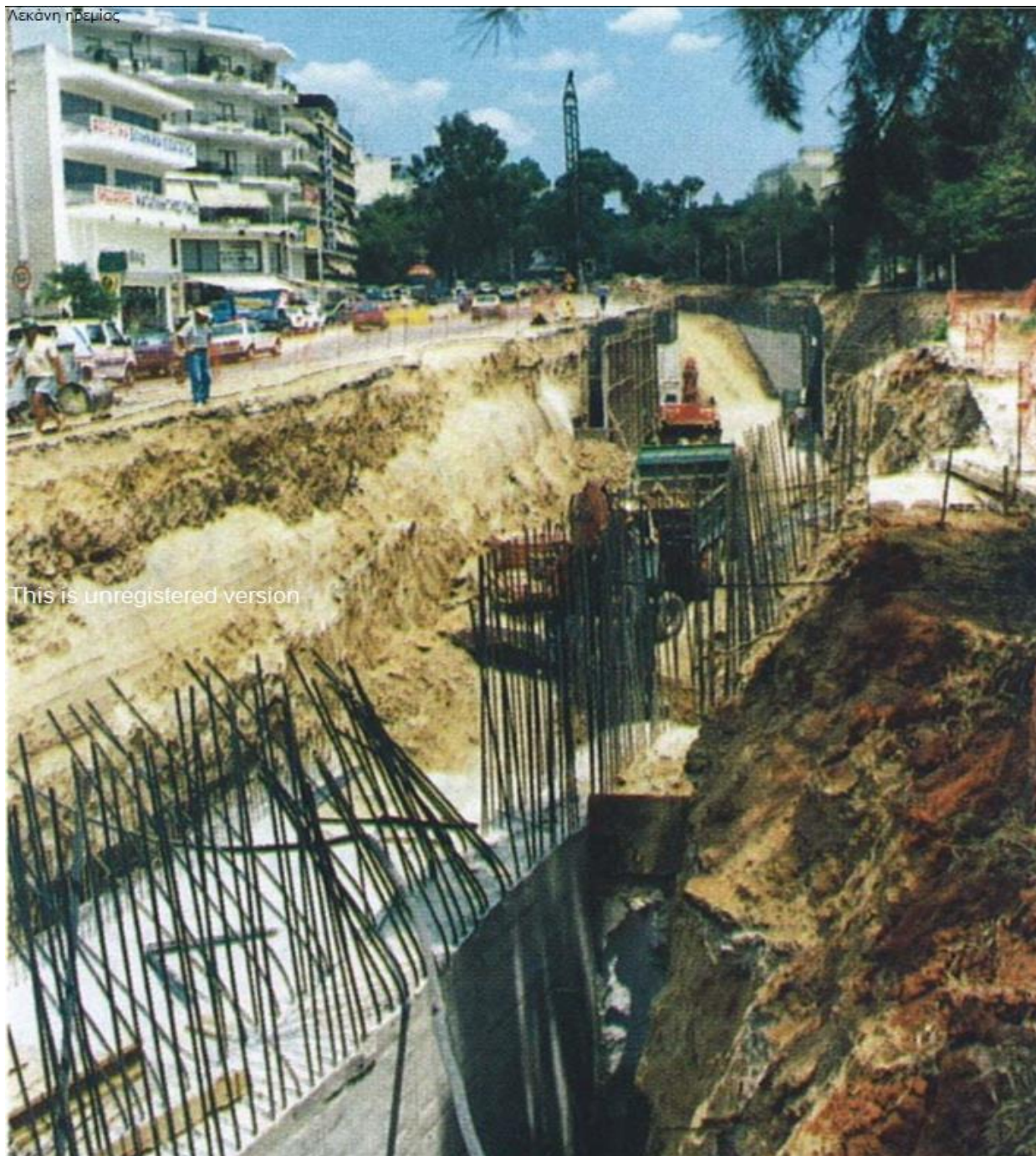
Εικόνα: Κατασκευή λεκάνης ηρεμίας κατά τη γ' φάση
