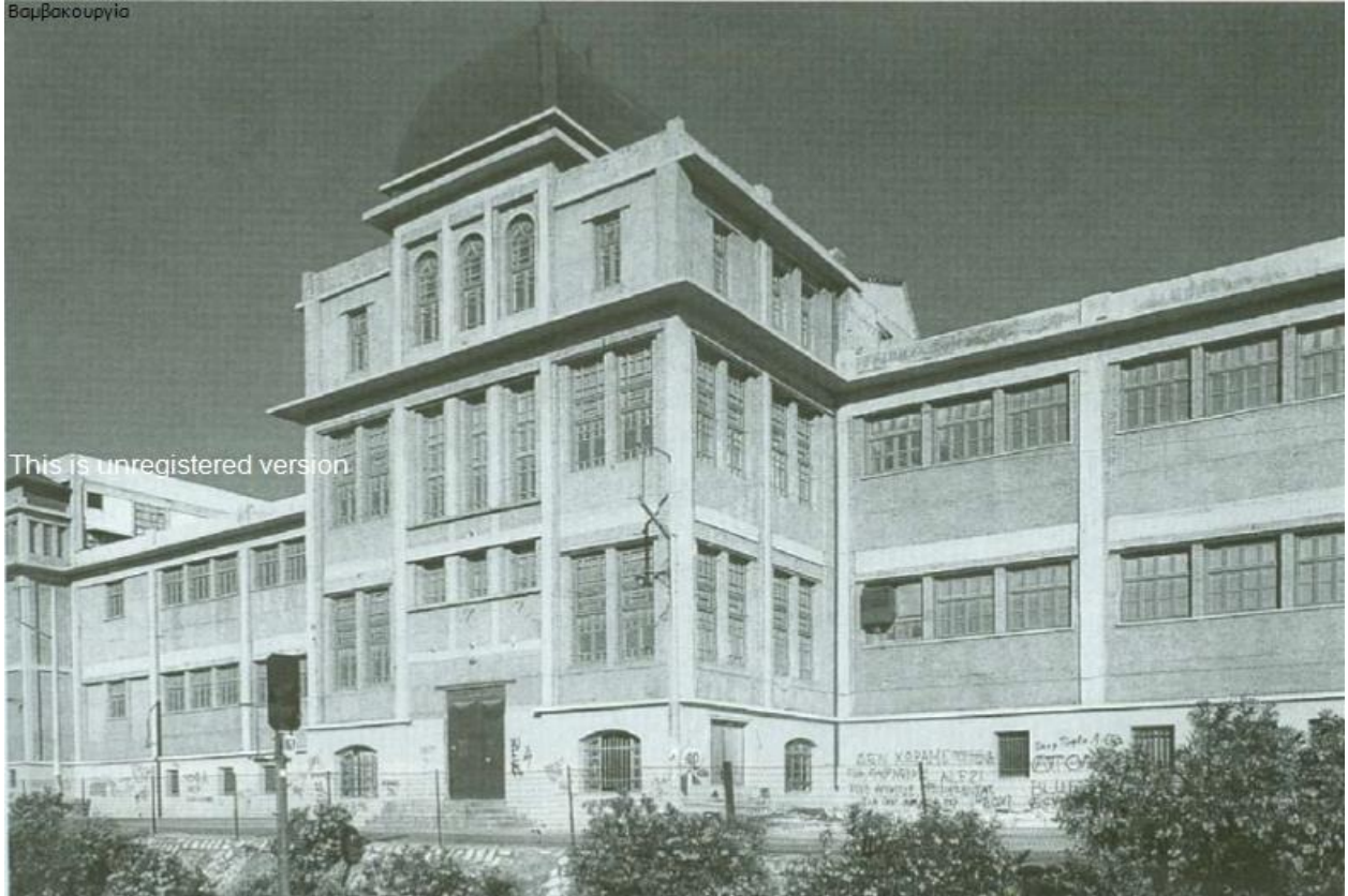
Εικόνα: Το εργοστάσιο της Βαμβακουργίας μετά την αποκατάστασή του το 1994. Πηγή: Μαΐστρου Ε., Βογιατζόγλου Ο., Καραθανάση Ε., Καλιοτζίδου Μ., «Η Βιομηχανική κληρονομιά της Νέας Ιωνίας», ΕΤΒΑ, 1985.
