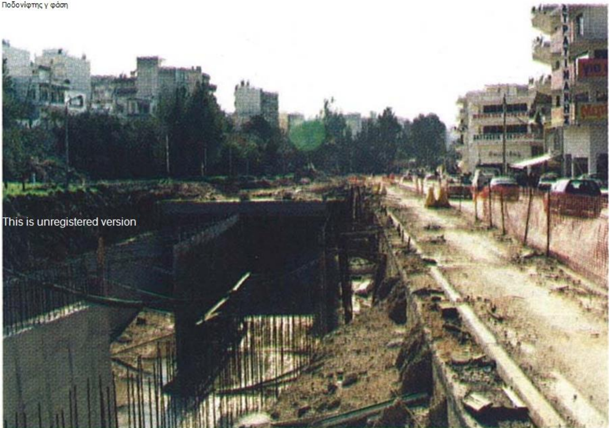
Εικόνα: Έργα στον Ποδονίφτη κατά την γ' φάση.
