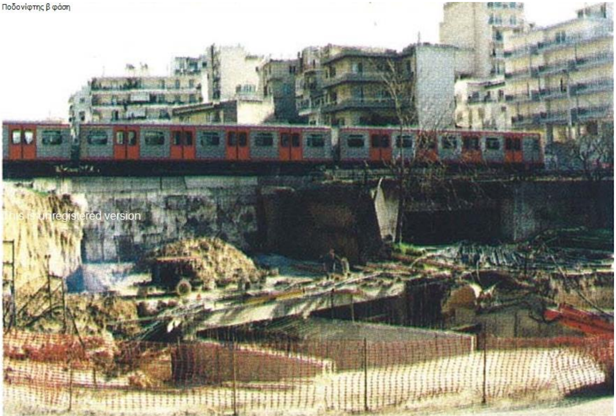
Εικόνα: Έργα στον Ποδονίφτη κατά την β' φάση.
