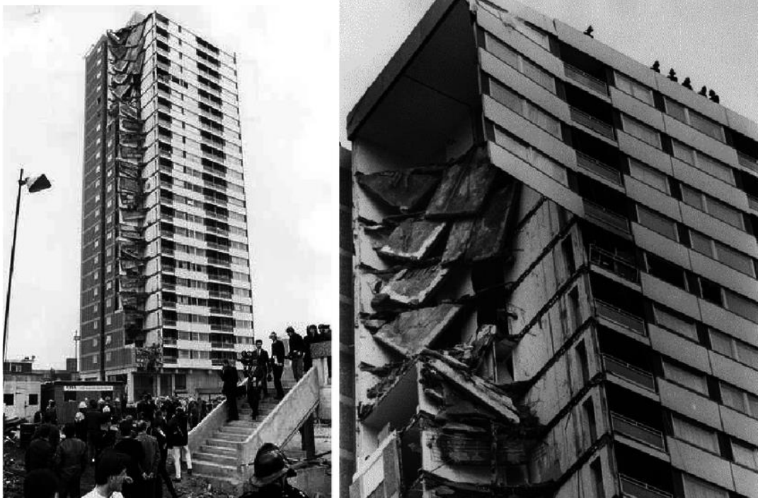
Εικόνα 1.1 : Προοδευτική κατάρρευση της πολυκατοικίας Ronan Point λόγω έκρηξης φυσικού αερίου.
