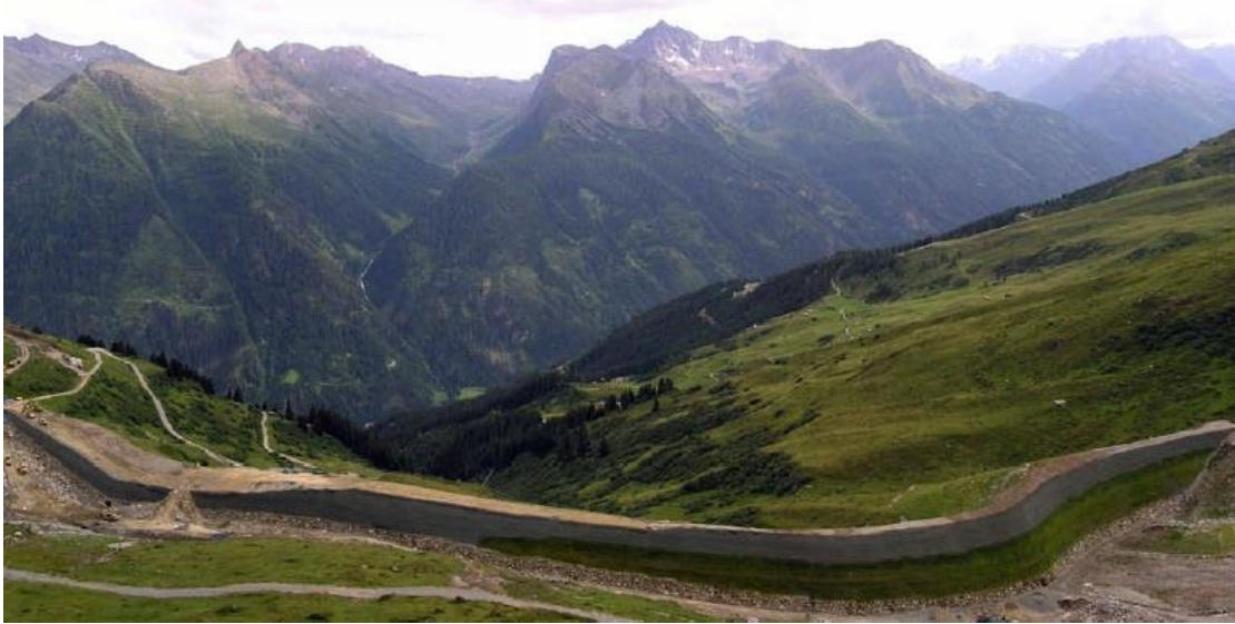
Εικόνα 2.22 : Επίχωμα ανάσχεσης βραχοπτώσεων στην Αυστρία ( www.tancate.com )
