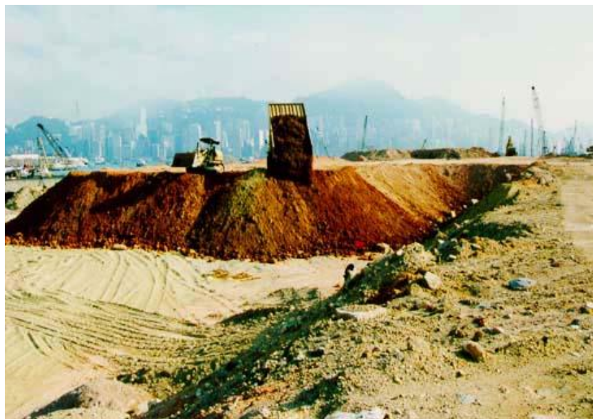
Εικόνα 2.19 : Επίχωμα για προφόρτιση στη φάση κατασκευής ( www.civcal.media.hku.hk )
