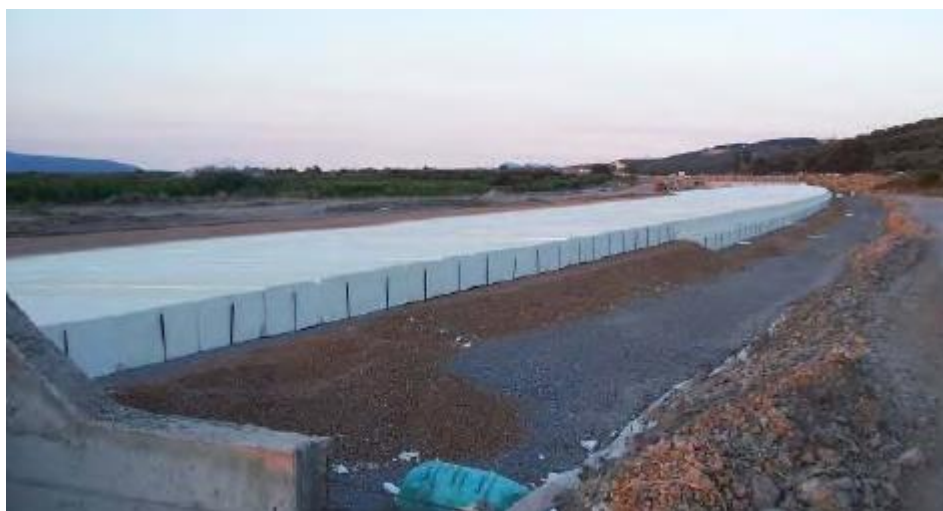
Εικόνα 3.8 :Αποψη ελαφρού επιχώματος κατά τη φάση κατασκευής (Παπαχαραλάμπους κ.α ,2010)
