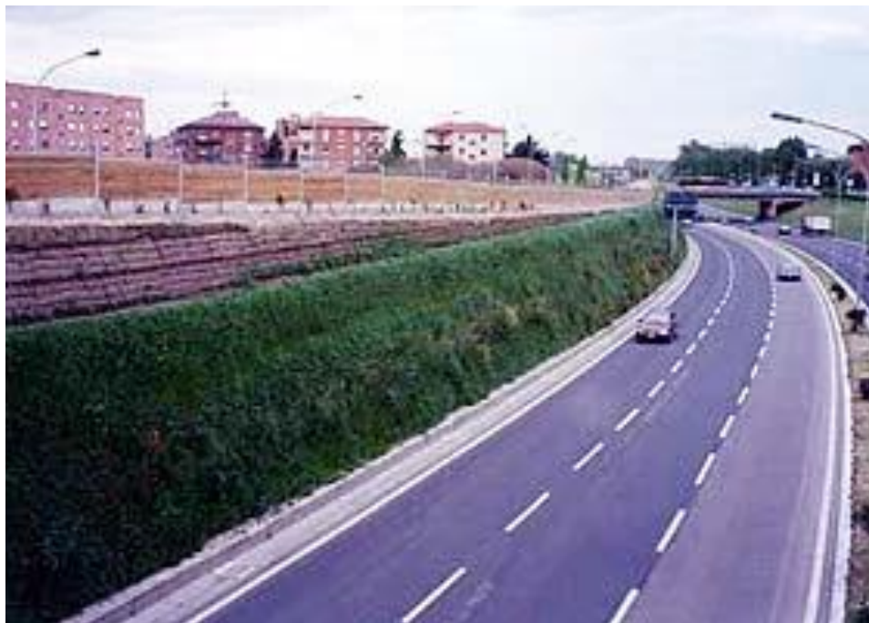
Εικόνα 2.12 : Χρήση οπλισμένου επιχώματος μεηχοπέτασμα στην στέψη ( www.tenax.net )
