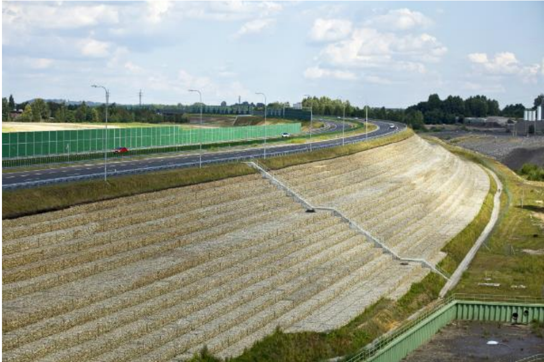
Εικόνα 3.14: Επίχωμα με επένδυση από συρματοκιβώτια
