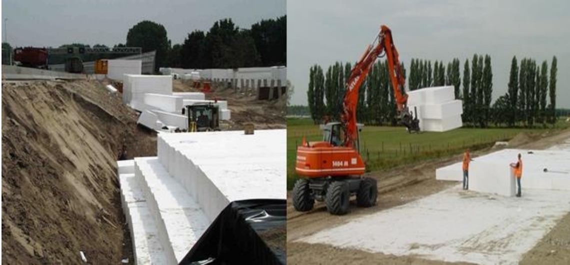
Εικόνα 2.26 : Επίχωμα οδοποιίας στην Εθνική Οδό – πέταλο Μαλιακού ( www.unisol.gr )
