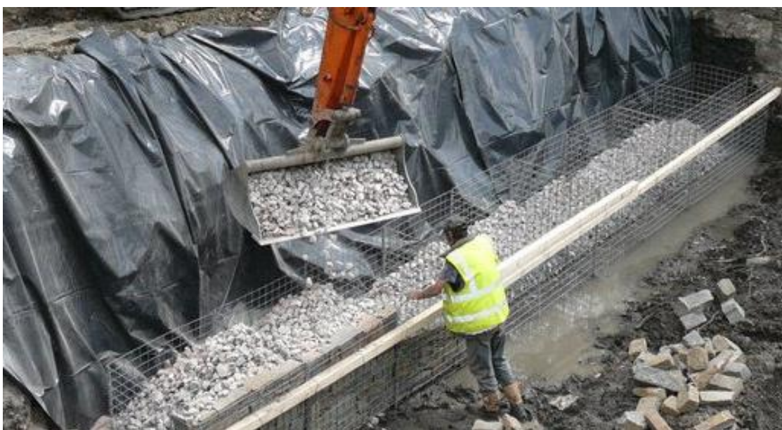
Εικόνα 3.15 : Γέμισμα συρματοκιβωτίου ( www.gabion1.com )
