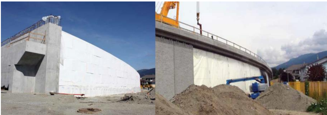
Εικόνα 2.27 : Μεταβατικό επίχωμα γέφυρας ( www.styropan.gr )
