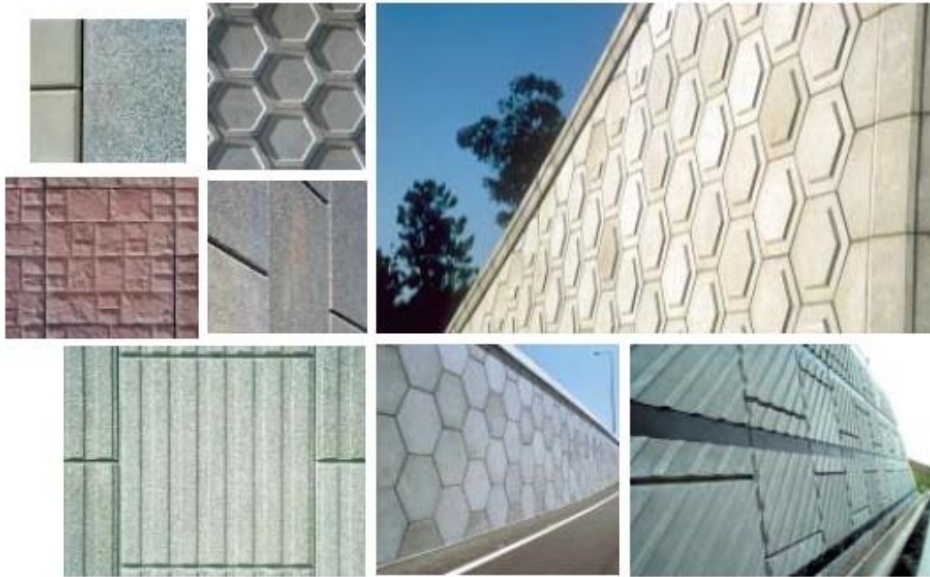
Εικόνα 3.23 : Διάφορα σχέδια προκατασκευασμένων στοιχείων από σκυρόδεμα ( www.vsl.com )
