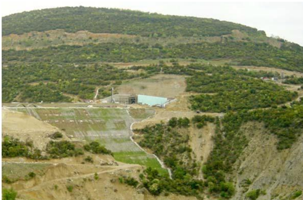
Εικόνα 3.17 : Άποψη του επιχώματος προς τα κατόντη μετά την ολοκλήρωση των εργασιών
