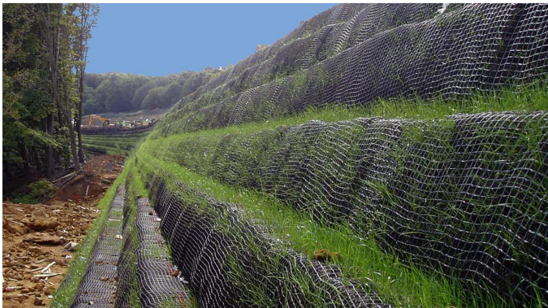
Εικόνα 2.8 : Επίχωμα με επένδυση από αναδιπλώσεις γεωπλεγμάτων
