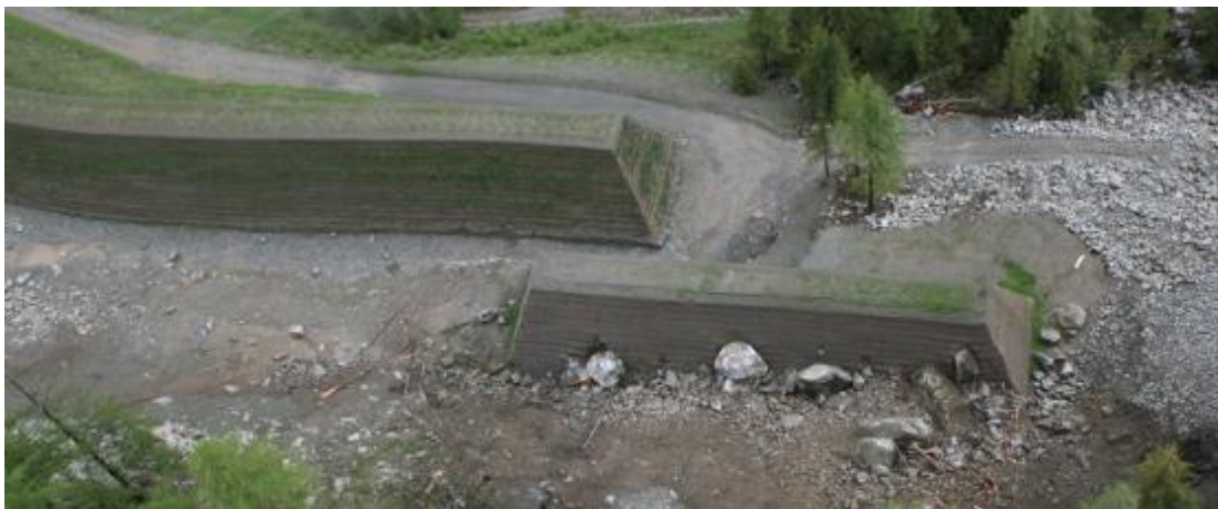
Εικόνα 2.21 : Επίχωμα ανάσχεσης βραχοπτώσεων ( www.maccaferri.com ).
