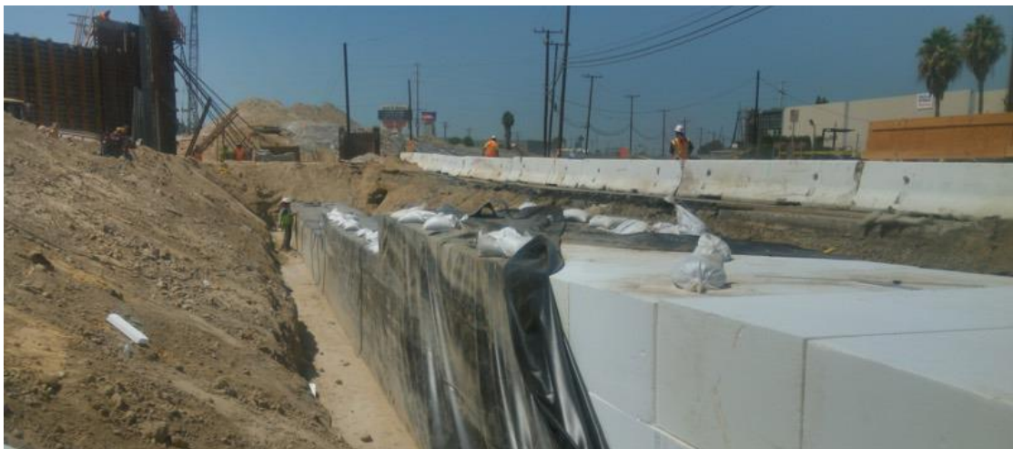
Εικόνα 3.10 : Γεωμβράνη για τη προστασία του γεωαφρού ( www.xrgeomembranes.com )
