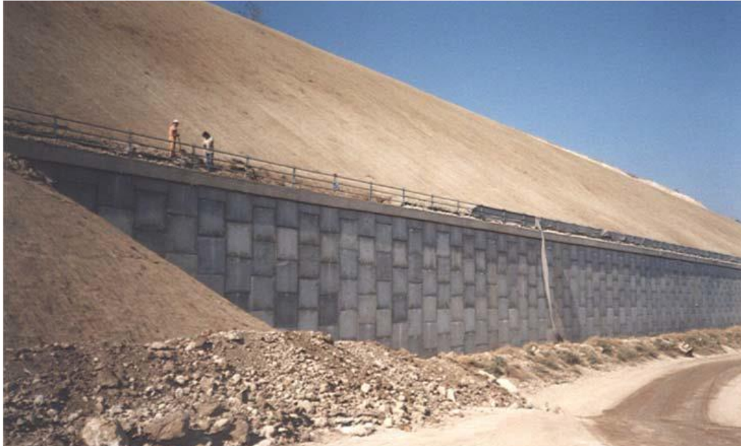
Εικόνα 3.20: Άποψη του επιχώματος κατά τη φάση κατασκευής ( www.omikronkappa.gr )
