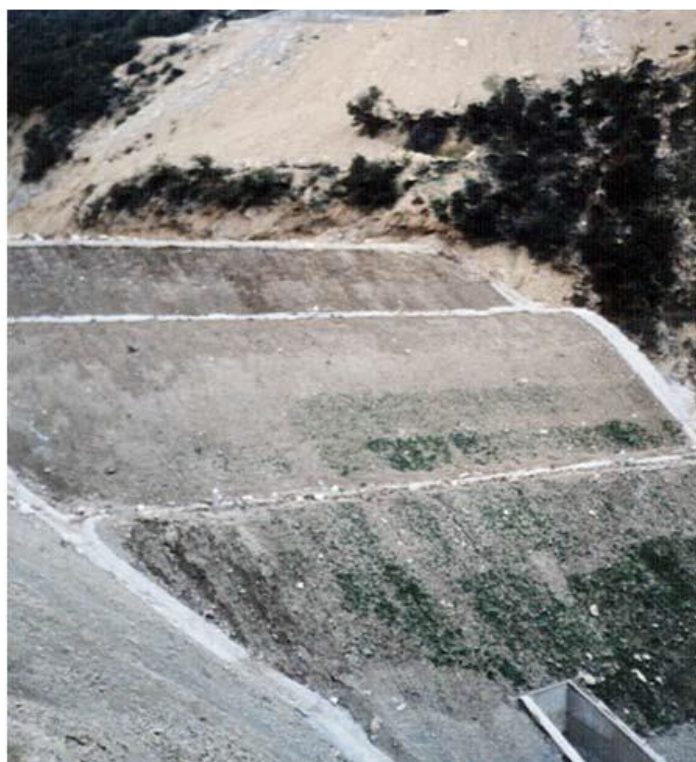
Εικόνα 3.16 :Άποψη του επιχώματος κατά τη φάση κατασκευής (www.omikronkappa.gr)
