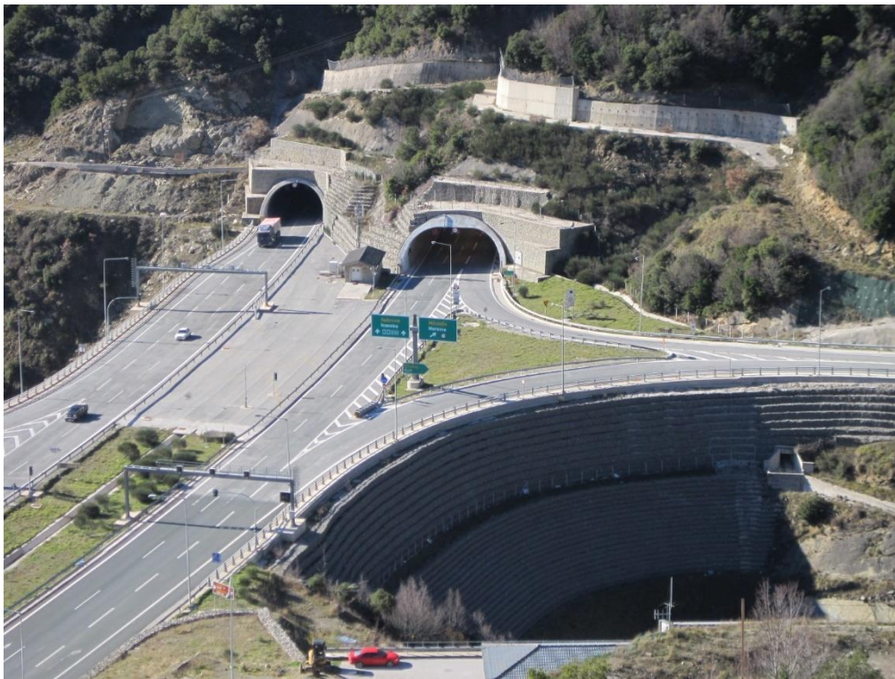
Εικόνα 2.9 : Οπλισμένο επίχωμα με συρματοκιβώτια σε έργο οδοποιίας, ο κόμβος Μετσόβου. ( www.geognosi.gr )
