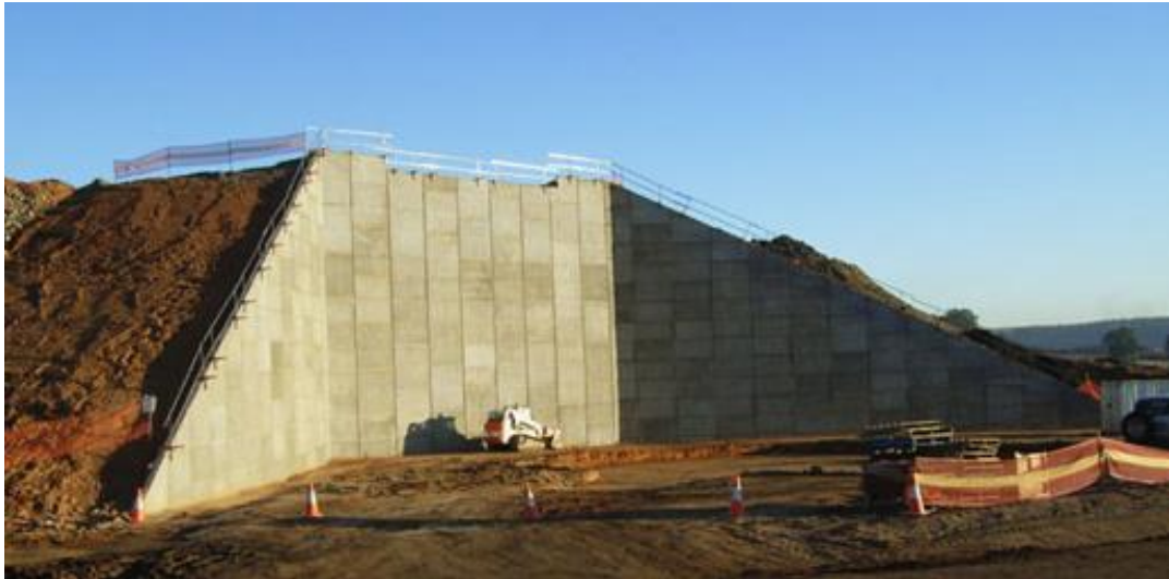
Εικόνα 2.6 Επίχωμα με επένδυση από προκατασκευασμένες πλάκες ( www.retainingsolutions.com )
