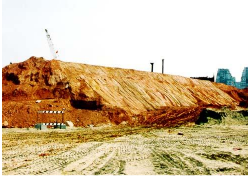
Εικόνα 2.20 : Επίχωμα για προφόρτιση ( www.civcal.media.hku.hk )
