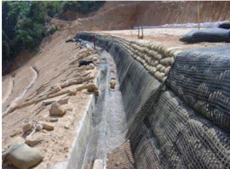
Εικόνα 3.4 : Γεωπλέγμα τυλιγμένο πίσω από τους σάκους του εδαφικού υλικού ( www.tencate.com )
