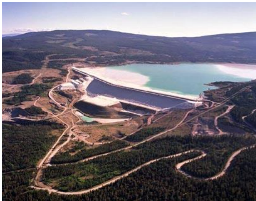
Εικόνα 2.24 : Επίχωμα μεταλλευτικού τέλματος στο LoganLake ( www.tailings.info )
