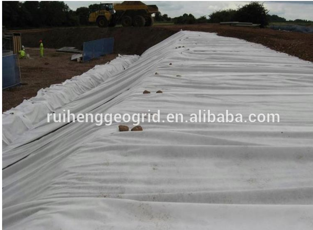
Εικόνα 3.19 : Μη υφαντό γεωφάσμα ενίσχυσης επιχώματος σιδηροδρομικού έργου ( www.alibaba.com )
