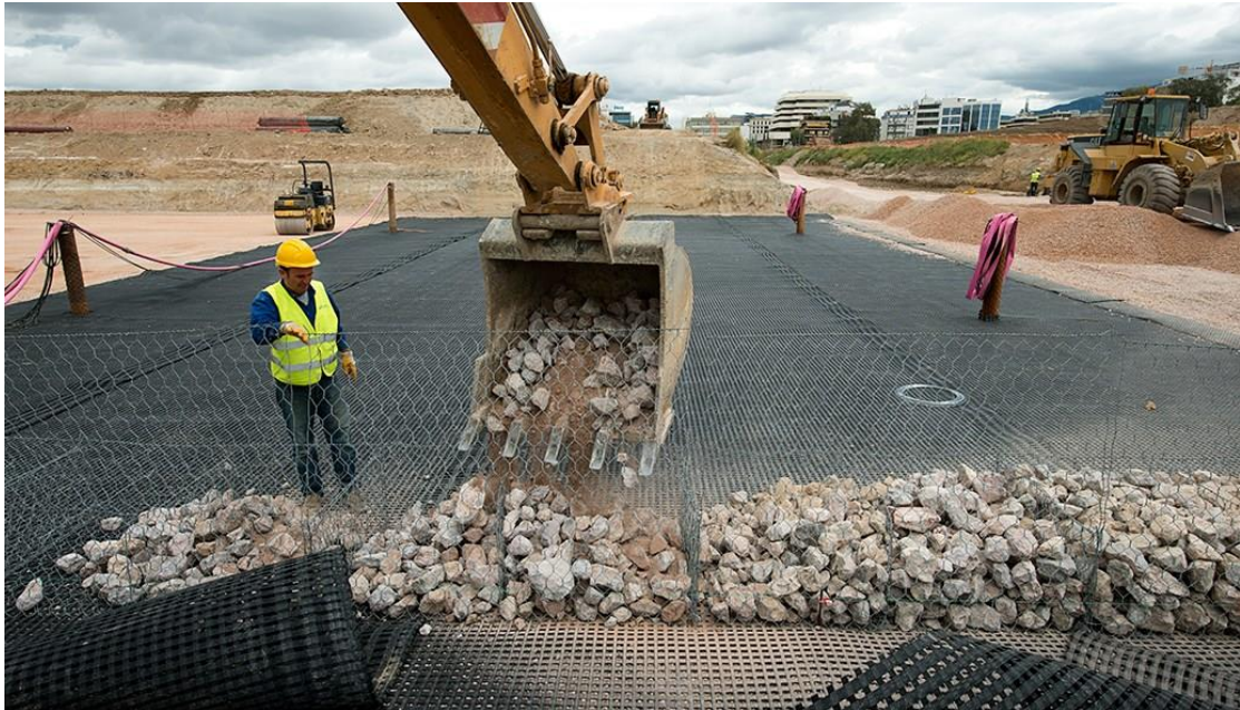
Εικόνα 3.29 : Πλήρωση συρματοκιβωτίων με το αδρανές υλικό ( www.snfcc.org )
