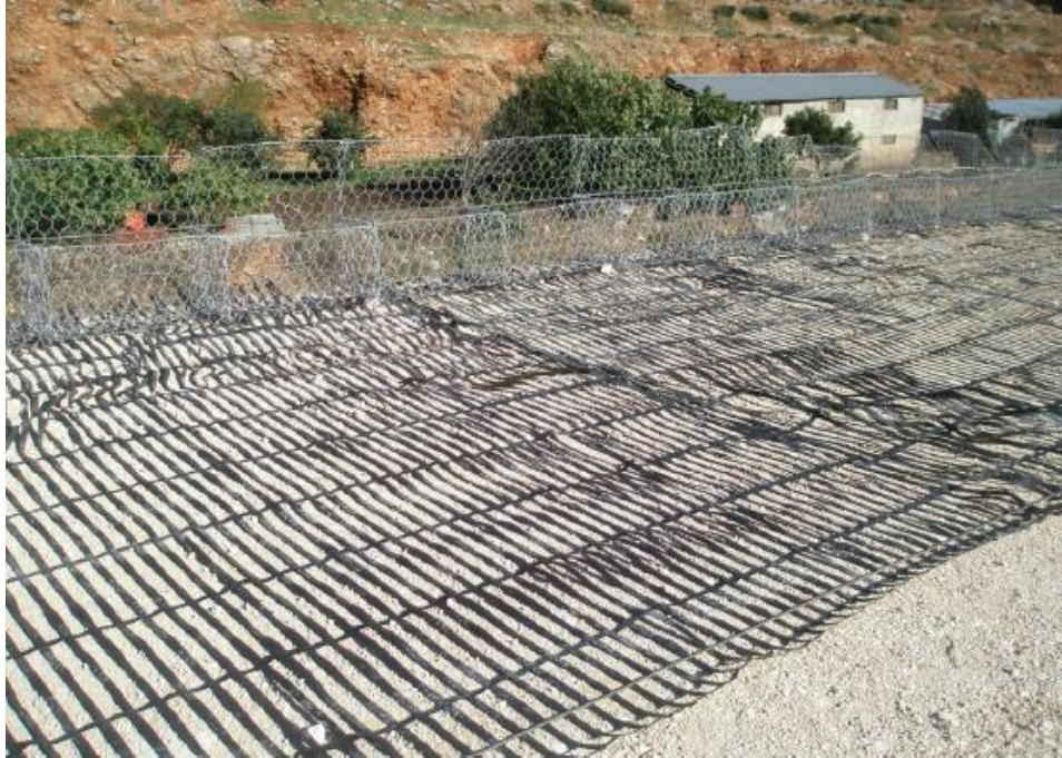
Εικόνα 3.6 : Γεωπλέγματα ως οπλισμός σε επίχωμα με επένδυση συρματοκιβωτίων( www.maccaferri.com )
