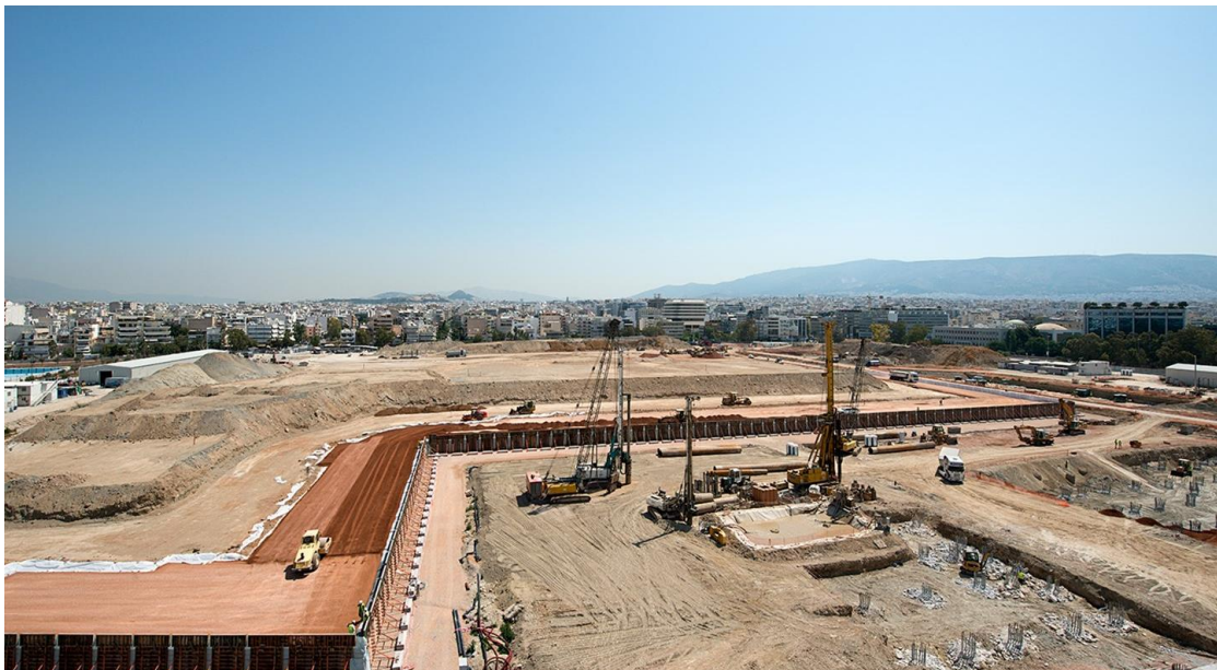
Εικόνα 3.27 : Εργασίες επίχωσης λόφου , νότια άποψη ( www.snfcc.org )
