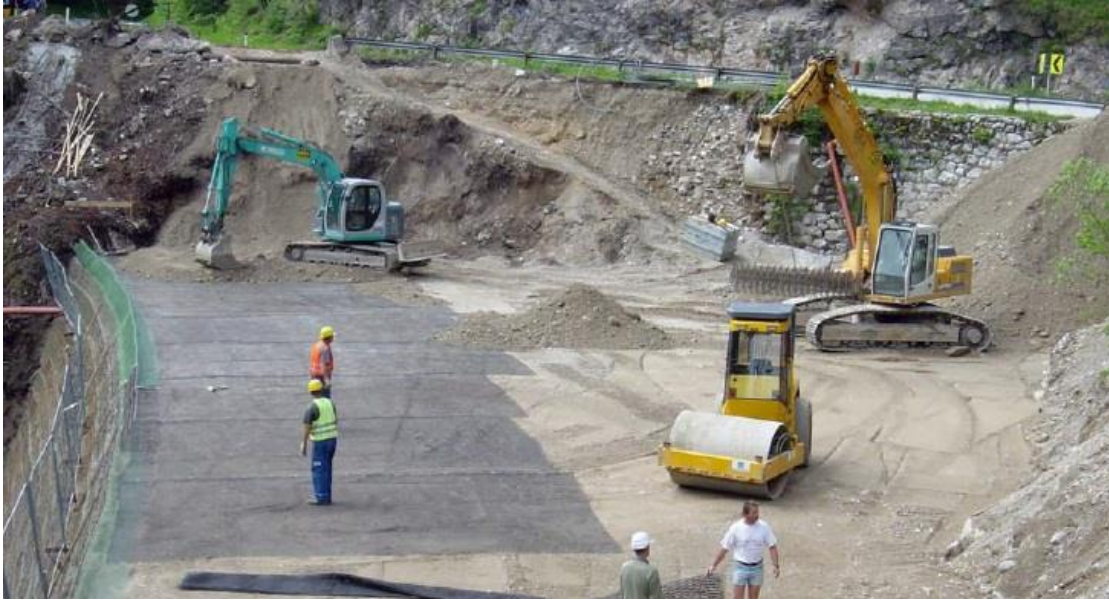
Εικόνα 2.14 : Οπλισμένο επίχωμα για την αντιστήριξης δρόμου (www.tencate.com)
