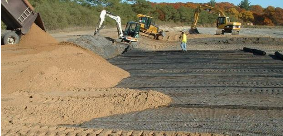
Εικόνα 2.4 Γεωπλέγμα ως υλικό οπλισμού επιχώματος (www.thracegroup.com)
