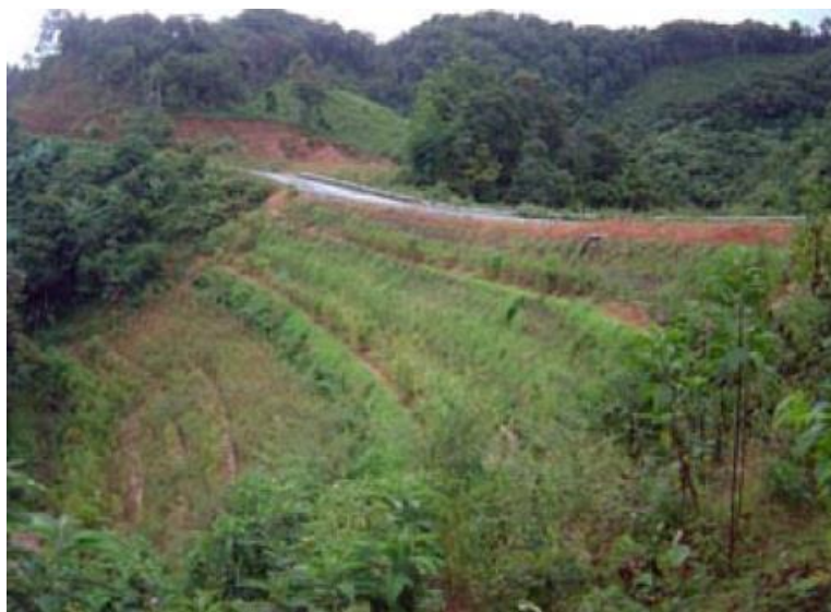
Εικόνα 3.5 : Τελική όψη επιχώματος ( www.tencate.com )
