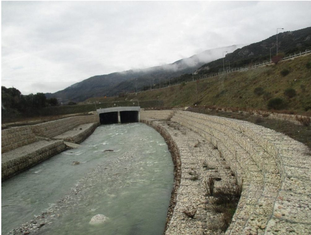
Εικόνα 2.17 : Επίχωμα για προστασία των όχθων του Μετσοβίτικου ποταμού αλλά και για την κατασκευή αντίβαρου σε κατολισθένουσα μάζα. (από Λουπασάκης)
