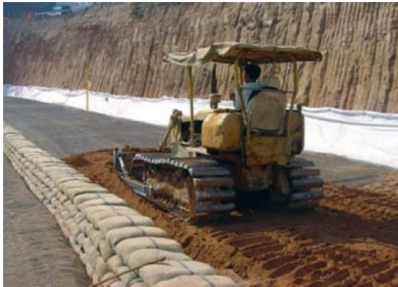
Εικόνα 3.3 : Διάστρωση εδαφικού υλικού πίσω από τους σάκους με το εδαφικό υλικό ( www.tencate.com )
