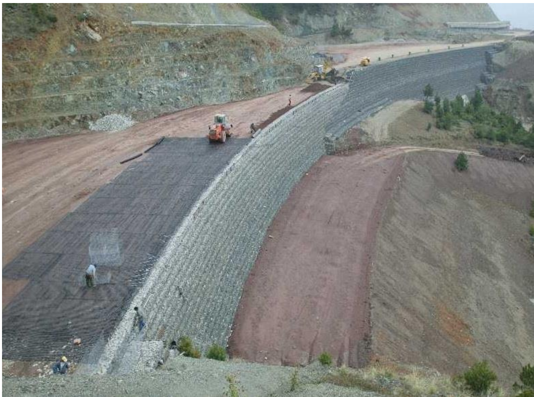
Εικόνα 2.13 : Οπλισμένο επίχωμα με συρματοκιβώτια ως μέσο αντιστήριξης
