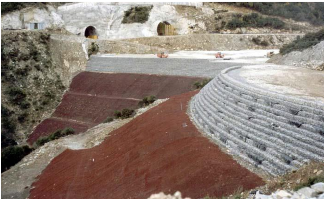
Εικόνα 3.12 : Ανατολική άποψη επιχώματος ( www.omikronkappa.gr )
