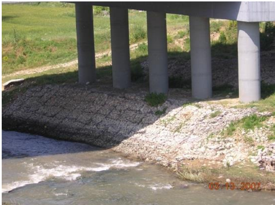
Εικόνα 2.18 : Επίχωμα ως επένδυση στη θεμελίωση γέφυρας (www.panmetal.gr)
