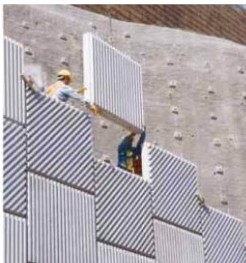
Εικόνα 3.22 : Τοποθέτηση προκατασκευασμένων στοιχείων από σκυρόδεμα ( www.vsl.com )
