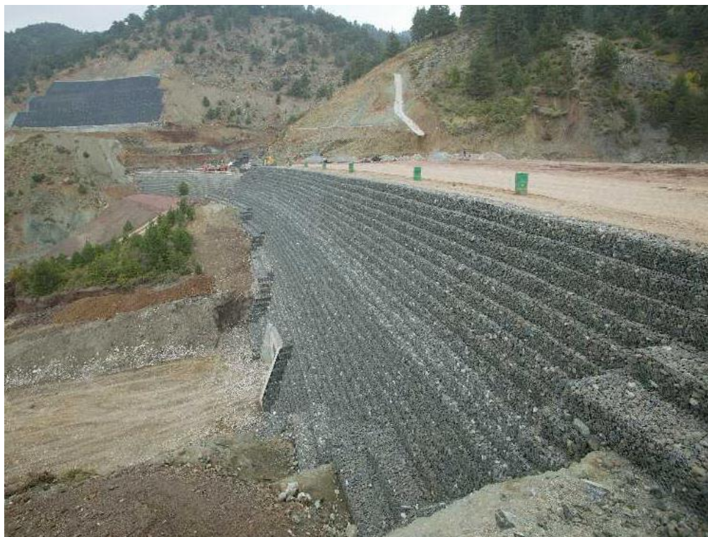
Εικόνα 2.10 : Οπλισμένο επίχωμα οδοποιίας στη φάση κατασκευής ( www.geognosi.gr )
