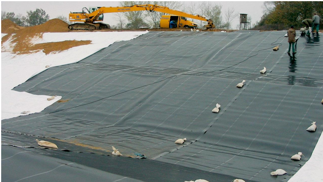
Εικόνα 3.9 : Γεωμεμβράνες κατά τη φάση κατασκευής μεταλλευτικού τέλματος ( www.naue.com )
