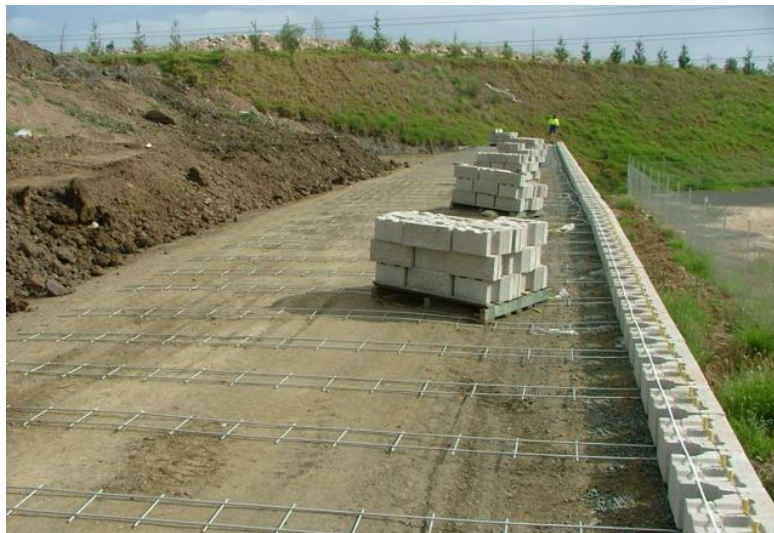
Εικόνα 2.5 Χαλύβδινος οπλισμός ως υλικό οπλισμού επιχώματος (www.thracegroup.com)
