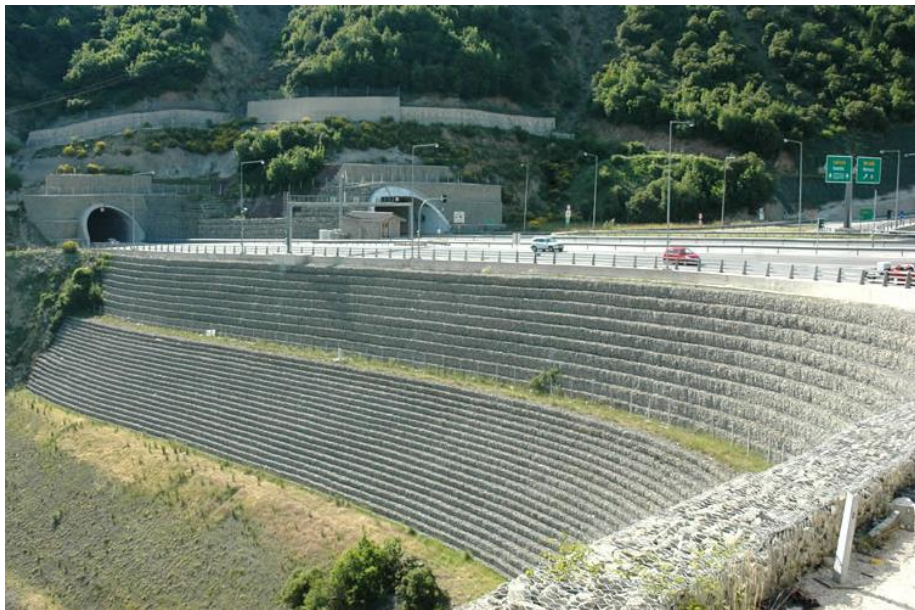
Εικόνα 2.7 Επίχωμα με επένδυση από συρματοκιβώτια ( www.gabion.gr )
