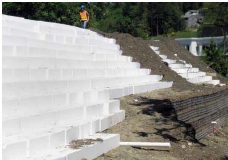
Εικόνα 2.28 : Επιχώματα αποκατάστασης/βελτίωσης ευστάθειας πρανών ( www.styropan.gr )
