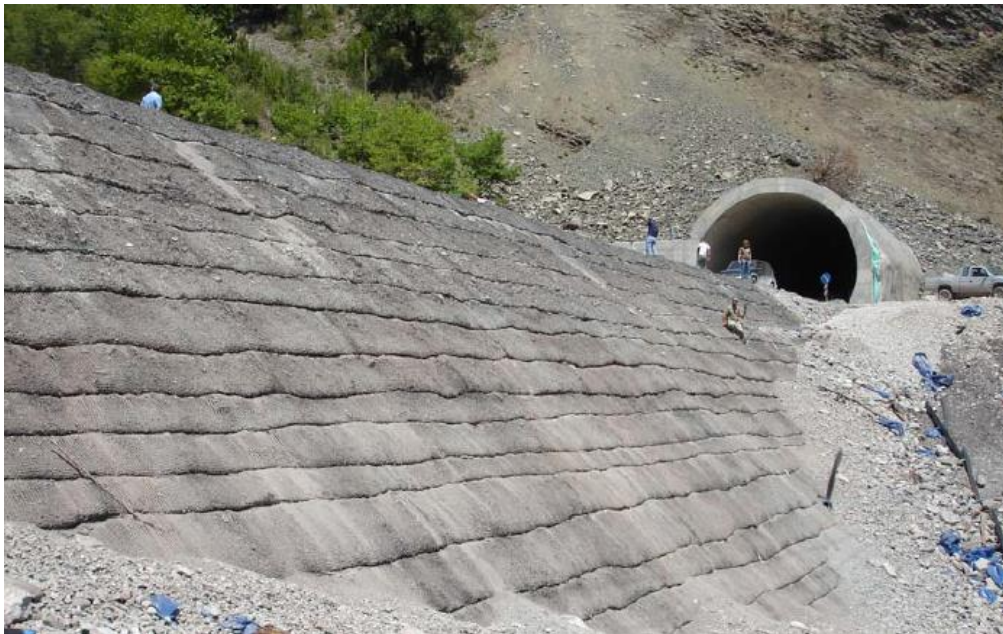
Εικόνα 3.2 : Άποψη επιχώματος κατά τη φάση κατασκευής (Φίκιρης και Μαυρομμάτη, 2007)
