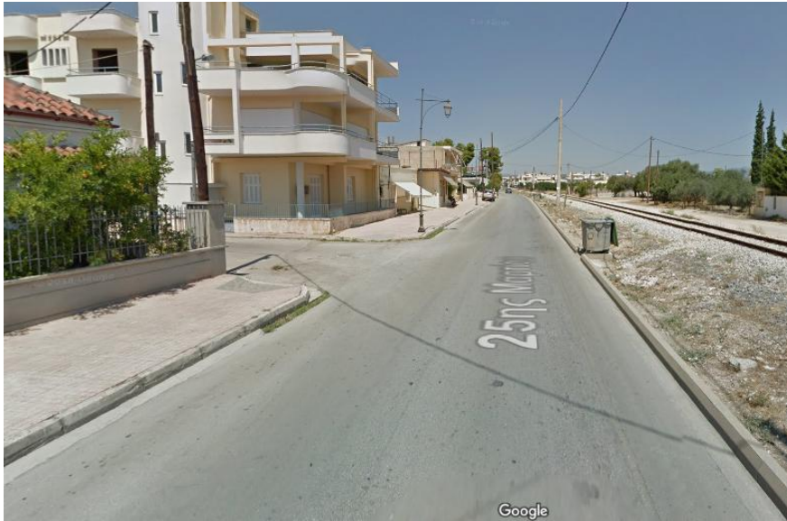
Εικόνα 77: Οδός 25ης Μαρτίου, Πηγή: Google street view
