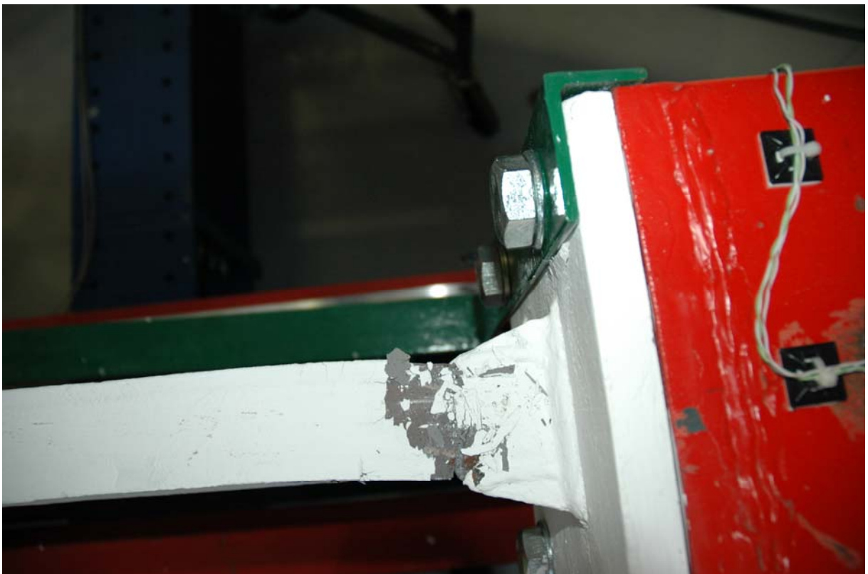
Φωτ. 5.1.7 . Κάτοψη περιοχής στήριξης του δοκιμίου 1 IPE 100, αρχή της αστοχίας, λεπτομέρεια
