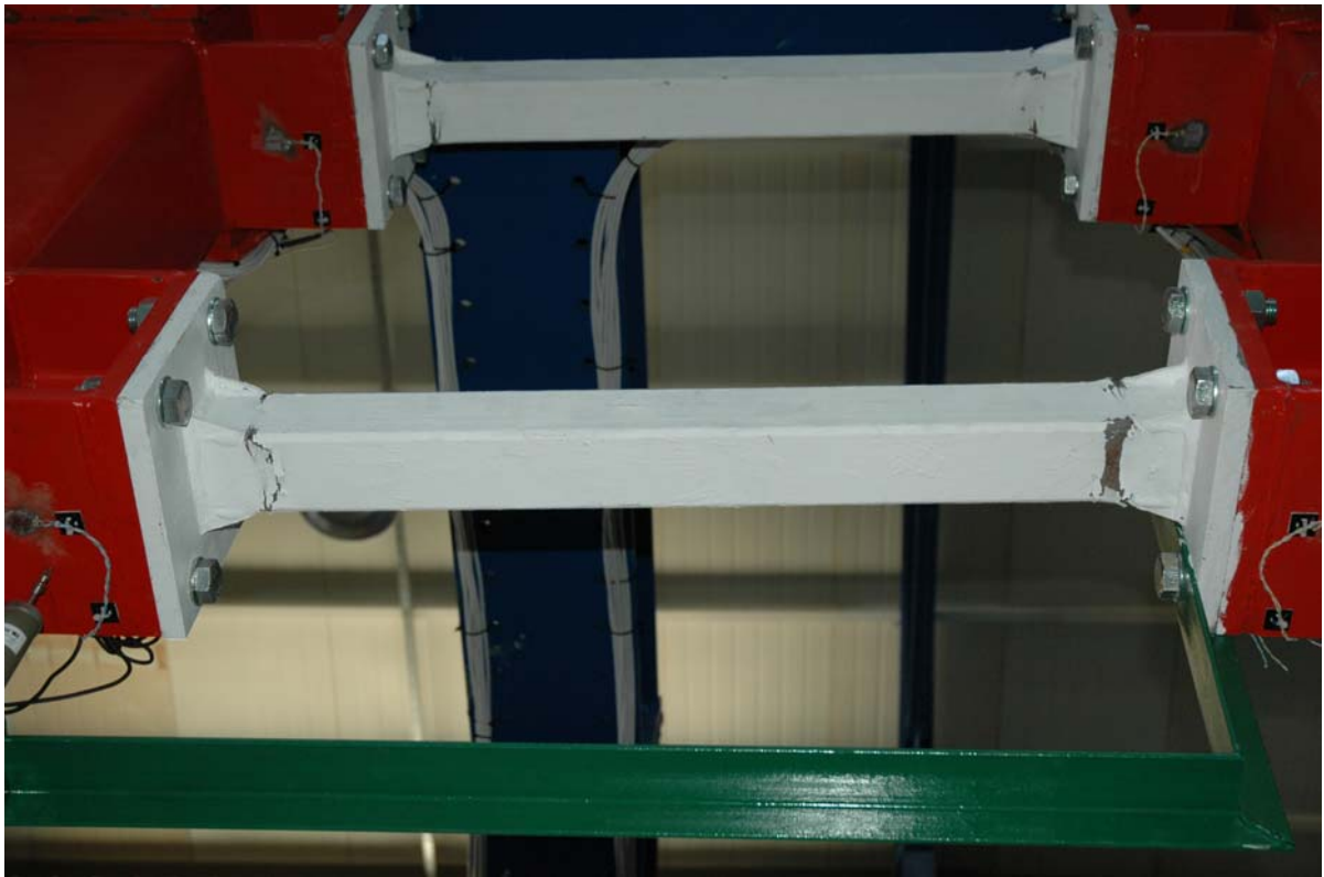
Φωτ. 5.3.4. Άνοψη δοκιμίου σε συνθήκες πλήρους αστοχίας (πείραμα 5 SHS 80/5)
