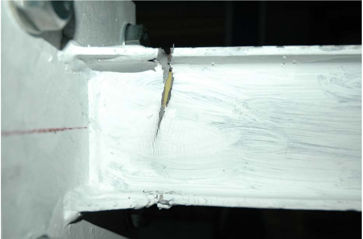
Φωτ. 5.2.7. Όψη του δοκιμίου (λεπτομέρεια) σε συνθήκες πλήρους αστοχίας (πείραμα 5 IPE 100)
