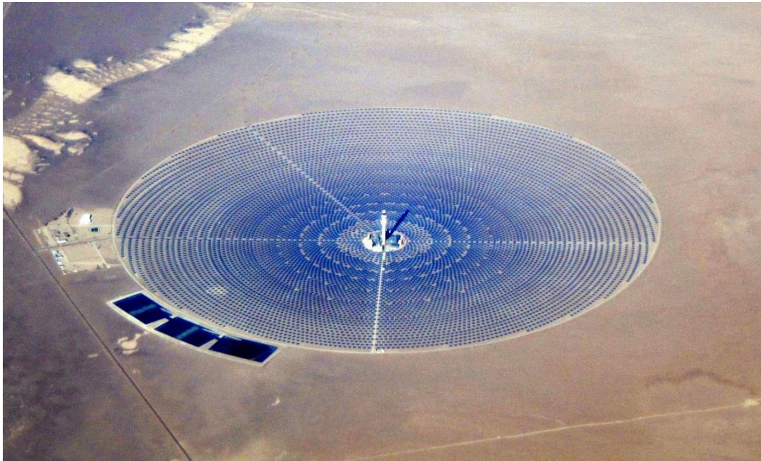
Εικόνα 3.7 : Ηλιακός πύργος από τον σταθμό Crescent Dunes Solar Energy Project (Η.Π.Α.) [110 MW] [3.13]
