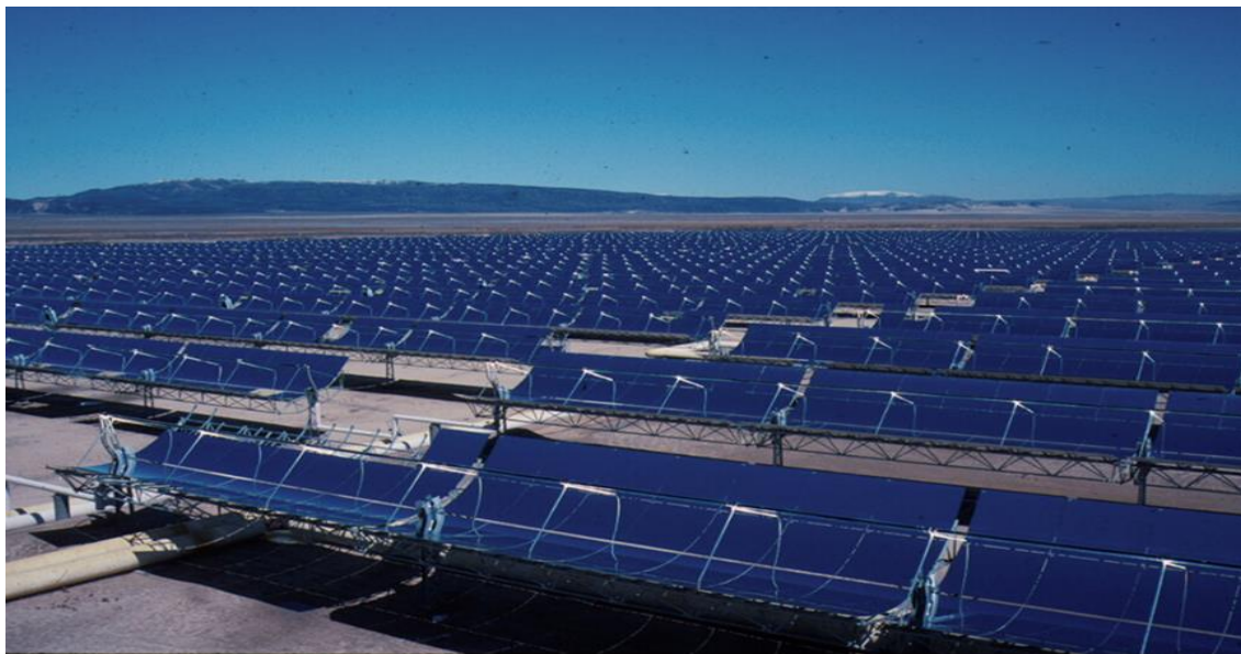
Εικόνα 3.9: : Παραβολικά κάτοπτρα από το σταθμό Solar Energy Generating Systems (SEGS) στην Καλιφόρνια (U.S.A.) [394 MW] [3.15]
