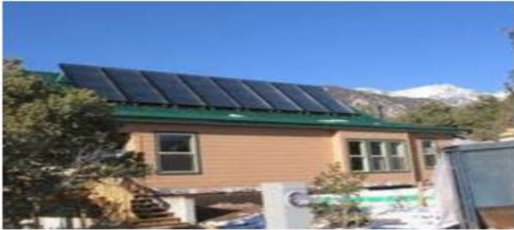
Εικόνα 3.35: Ενσωμάτωση κεντρικού θερμικού ηλιακού συστήματος σε κτίριο [3.31]
