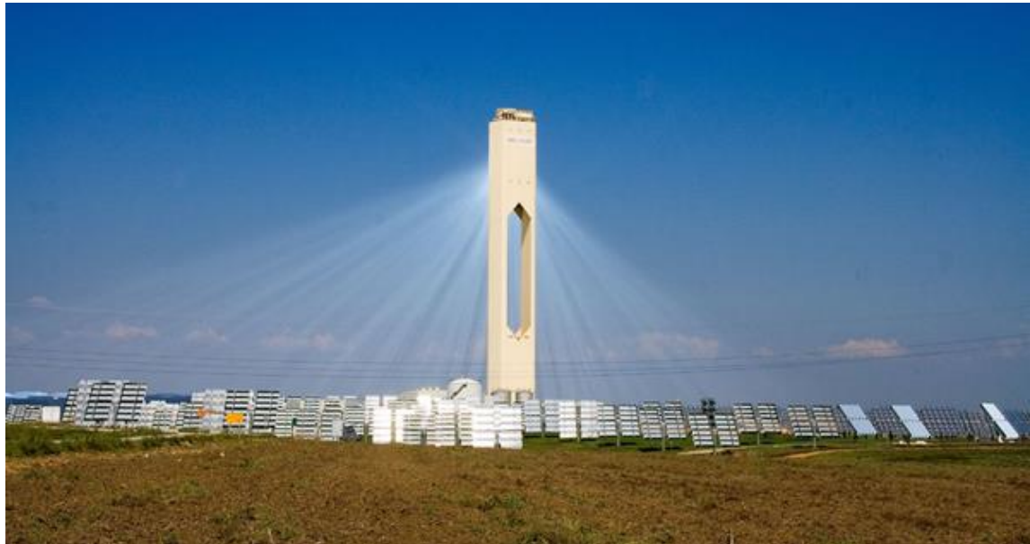
Εικόνα3.6 : Ηλιακός πύργος από τον σταθμό PS10 (Ισπανία) [11 MW] [3.13]
