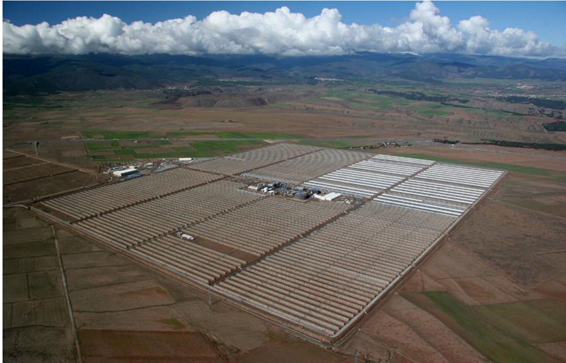
Εικόνα 3.10 : Παραβολικά κάτοπτρα από το σταθμό Andasol solar power station στην Ισπανία [150 MW] [3.15]
