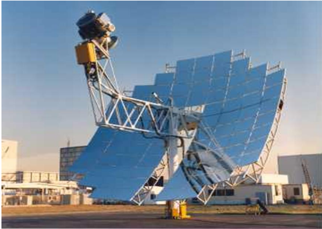
Εικόνα 3.16: Ηλιακός δίσκος με μηχανή stirling [3.18]
