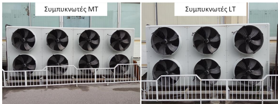
Σχήμα 4.10: Συμπυκνωτές κυκλωμάτων ΜΤ και LT
