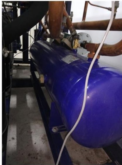
Σχήμα 4.11: Δεξαμενή αποθήκευσης ψυκτικού υγρού κυκλώματος MT
