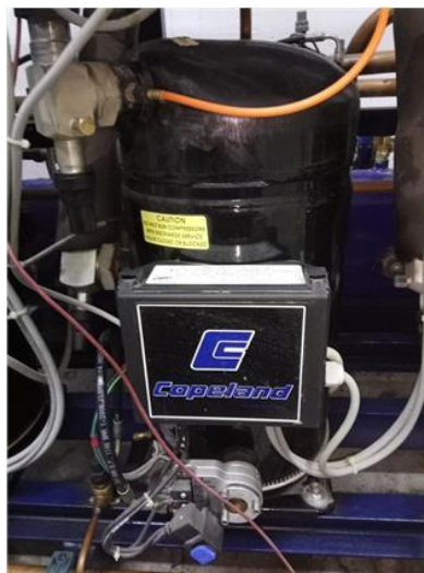
Σχήμα 4.9: Φωτογραφία scroll συμπιεστή του κυκλώματος LT
