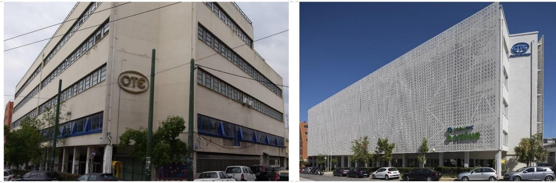
Εικόνα 5.6: Παλιό κτίριο OTE (ανέγερσης 1959) - Kerameikos Office Building LEED v3 Gold
