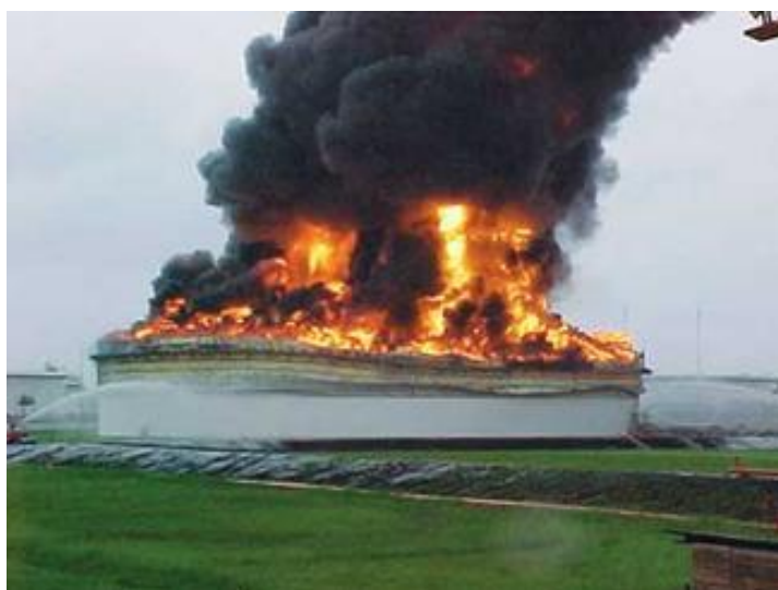
Εικόνα 2.1 Πυρκαγιά σε όλη την επιφάνεια μίας δεξαμενής αποθήκευσης (tank fire) που βρίσκεται σε μία έκταση αποθήκευσης πετρελαίου [ 10].
