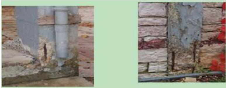
Εικόνα 12: Αποφλοίωση σκυροδέματος και διάβρωση οπλισμού στο πόδα του υποστυλώματος λόγω ανερχόμενης υγρασίας [21]
