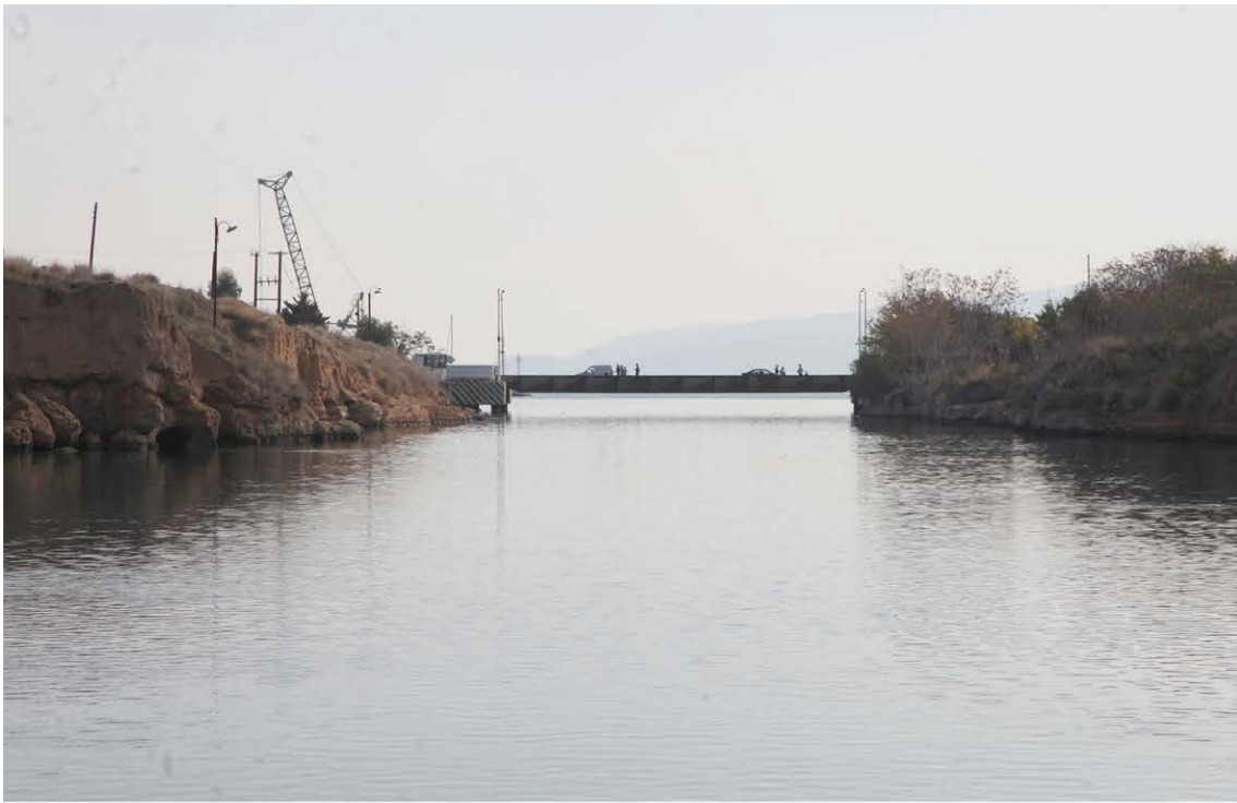
Εικ.8: Βυθιζόμενη γέφυρα Ισθμίων.
