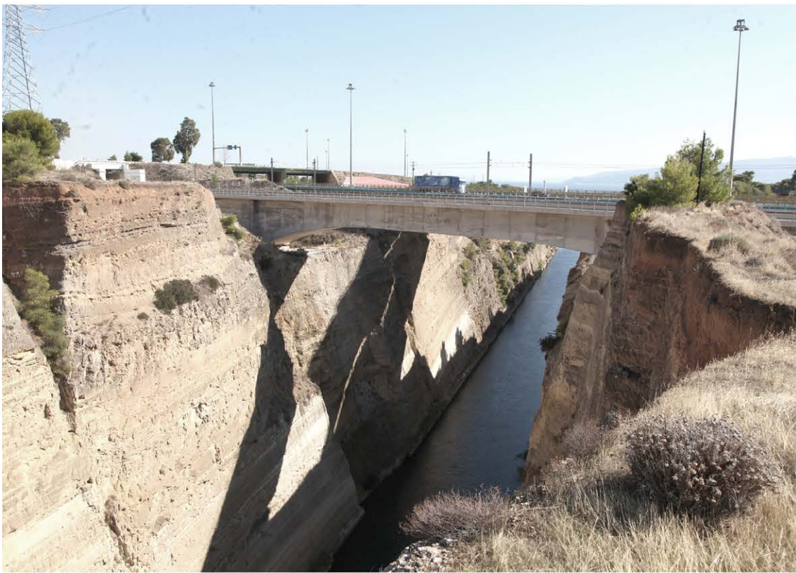
Εικ.9: Άποψη γέφυρας της Νέας Εθνικής οδού από την Πελοπόννησο.
