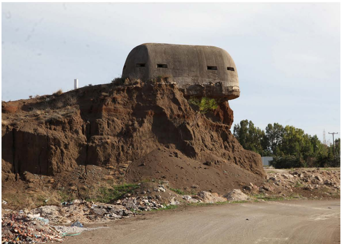
Εικ. 5: Πολυβολείο, σε περιοχή παράνομων εκωματώσεων
