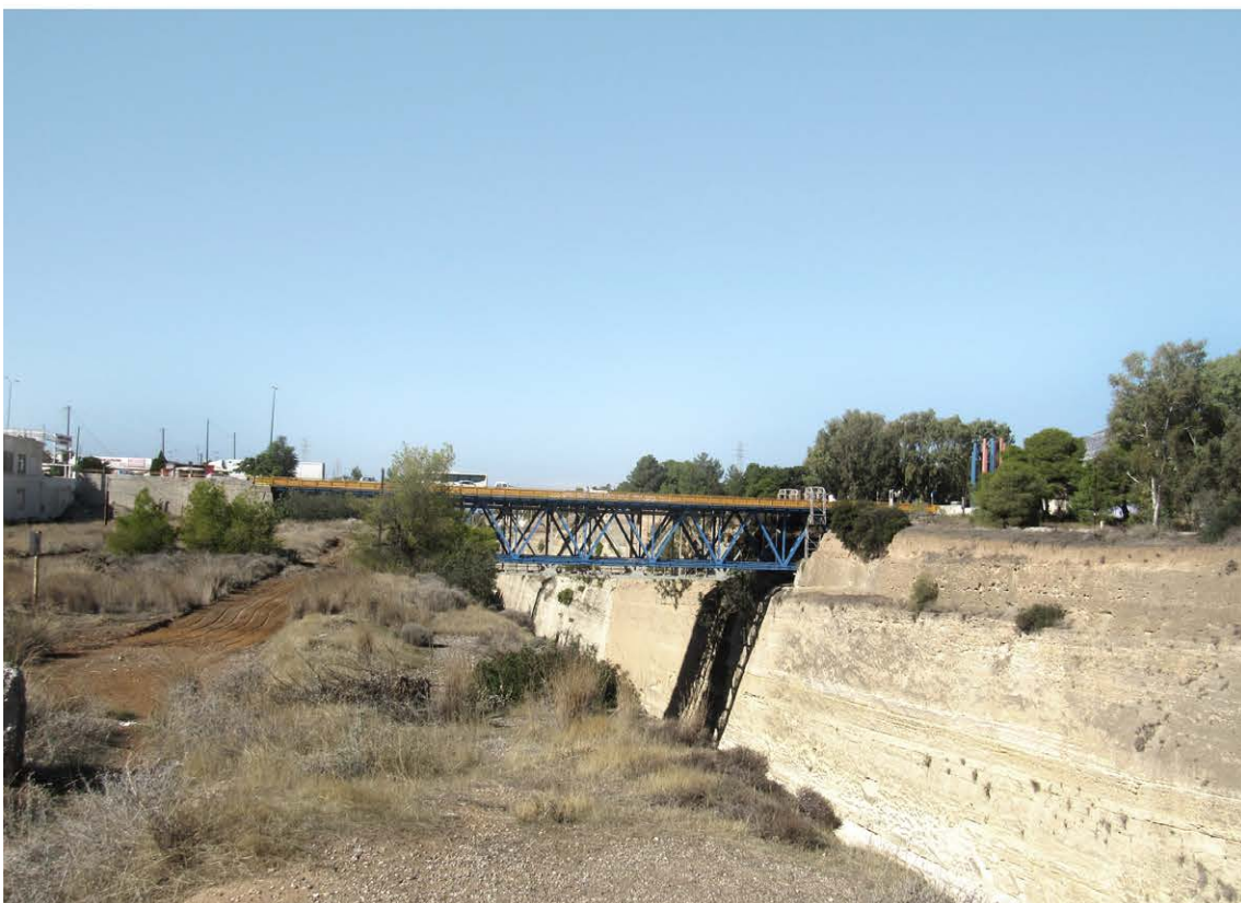
Εικ.10: Άποψη της γέφυρας της Παλιάς Εθνικής Οδού από την Πελοπόννησο.
