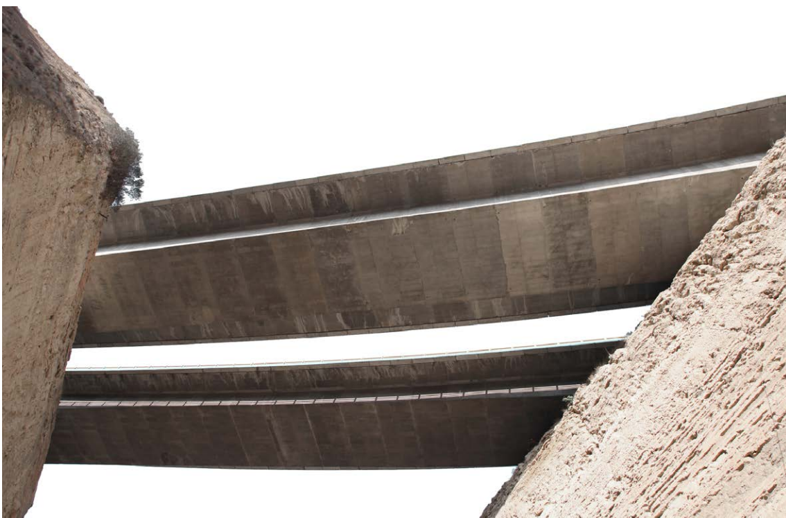
Εικ 6. : Η γέφυρα της Νέας Εθνικής Οδού δημιουργεί ασυνέχειες στο χερσαίο δίκτυο ενώ ταυτόχρονα οι μεγάλες ταχύτιπες διέλευσης παρεμποδίζουν οποιαδήποτε οπτική επαφή με το νερό και την υπόσταση της Διώρυγας.
