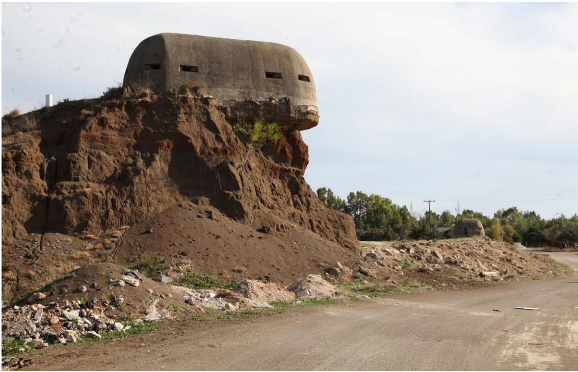
Εικ. 6: Πολυβολείο, σε περιοχή παράνομων εκκωματώσεων
