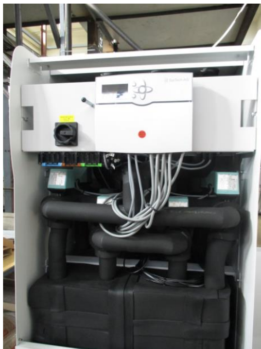
Σχήμα 2.4: Εικόνα του εμπορικού ψύκτη προσρόφησης eZea 10 IPS.
