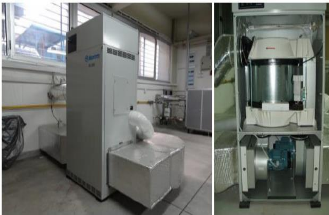
Εικόνα 3.22: Εγκατάσταση ψύξης και αφύγρανσης στερεού προσροφητικού μέσου της Σχολής Μηχανολόγων Μηχανικών του Εθνικού Μετσόβιο Πολυτεχνείου [3.12]
