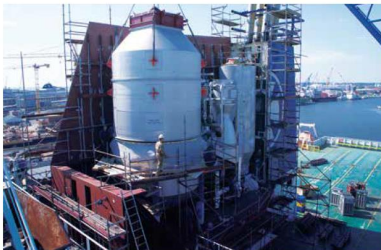
Εικόνα 17 Scrubber installation on Ficaria Seaways (13)
