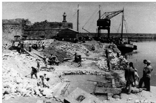
Εικ.30. Εργασίες επέκτασης λιμανιού
