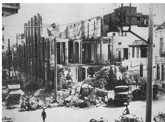
Εικ.42. Καταστροφή του Ναού του Σωτήρος
