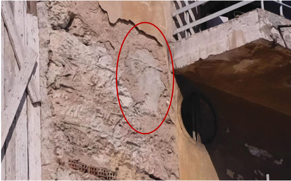
Εικόνα 17 (Πιθανή απώληξη δοκαριού)
