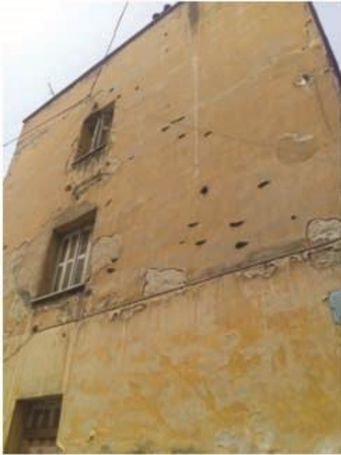
Εικόνα 19(Ιχνη οβίδων κατά τις μάχες των Δεκεμβριανών), 20(Αποφλοιώσεις, αποκολλήσεις επιχρισμάτων)
