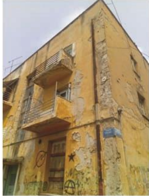
Εικόνα 19(Ιχνη οβίδων κατά τις μάχες των Δεκεμβριανών), 20(Αποφλοιώσεις, αποκολλήσεις επιχρισμάτων)
