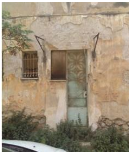
Εικόνα 26 (Αυθαίρετη επέμβαση μετατροπής παραθύρου σε πόρτα)
