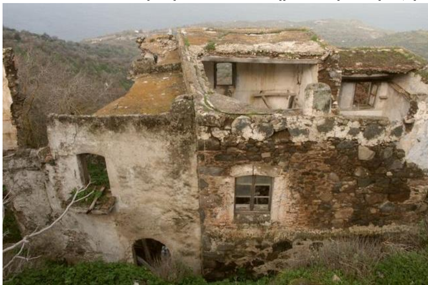
Εικόνα 76. Αποκατάσταση παραδοσιακού κτηρίου στη Νίσυρο (πριν)
