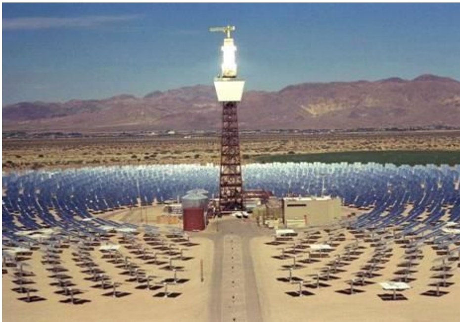
Σχήμα 2.9: Ο πιλοτικός ηλιακός πύργος στη Dagget στην Αμερική ισχύος 10 MW . [2.10]
