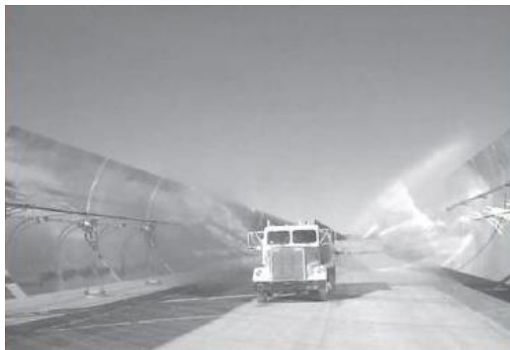
Σχήμα 2.13: Πλύσιμο ηλιακών συλλεκτών με πεπιεσμένο νερό. [2.1]
