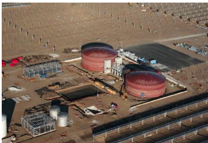
Σχήμα 2.15 : Δεξαμενές αποθήκευσης σε εργοστάσιο. [2.11]
