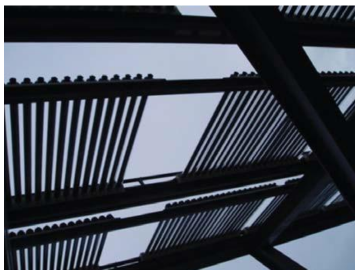
Σχήμα 5.2.6.3. Ηλιακές συστοιχίες σε ανατολική πλευρά [300]
