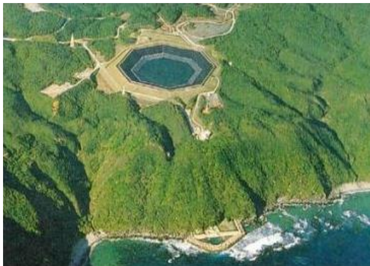
Εικόνα 3.3: Αντλητικός σταθμός Οκινάουας με θαλασσινό νερό [40]
