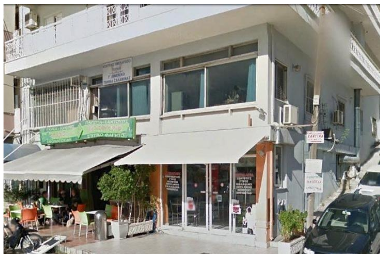
Εικόνα 4.1: Κτίριο με χρήση γραφείων
