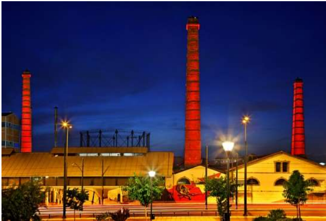
Εικόνα 6 : Τεχνόπολις στο Γκάζι, πηγή : http://www.mytheatro.gr/tecnopolis-gkazi/
