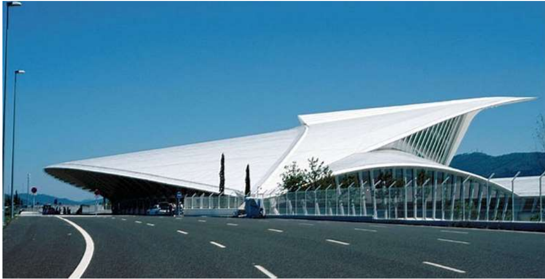
Εικόνα 3: Το νέο Αεροδρόμιο του Μπιλμπάο, πηγή:
