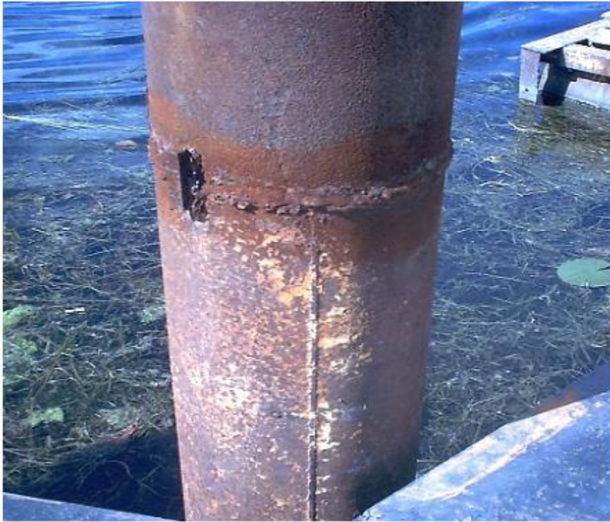
Εικόνα 14. Ομοιόμορφη διάβρωση [37]
