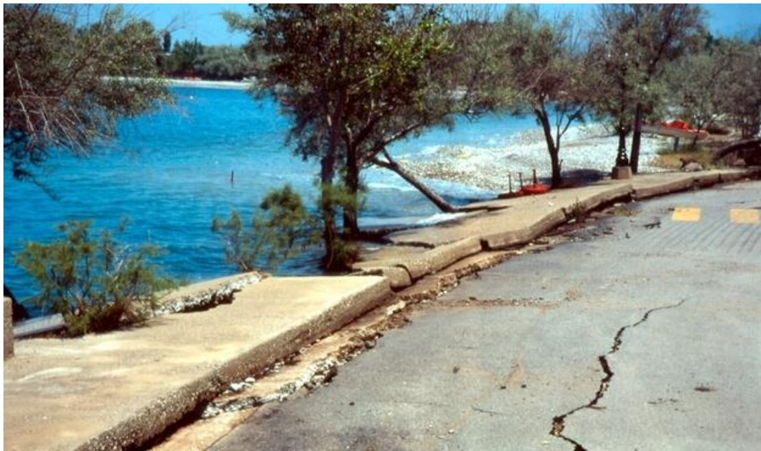
Εικόνα 184: Παραλιακή ζώνη στα Νικολέϊκα μετά το σεισμό του 1995. Πηγή: http://www.elekkas.gr/menu11h/sc-photos/g1995/aigio95.html
