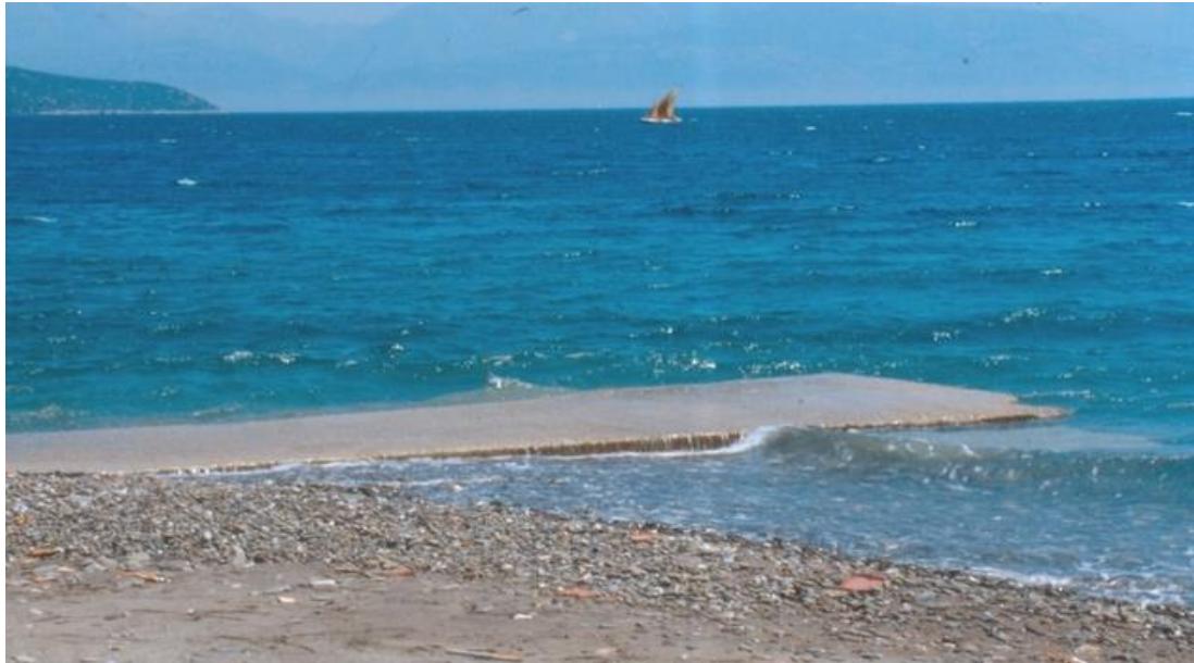
Εικόνα 185: Βυθισμένη Προβλήτα έπειτα από το σεισμό του 1995 στην ευρύτερη παραλιακή ζώνη της Αιγιαλείας. Πηγή: http://www.elekkas.gr/menu11h/sc-photos/g1995/aigio95.html
