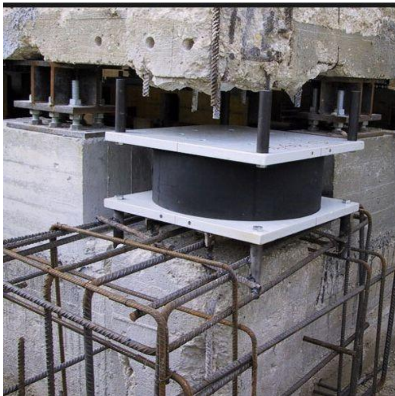
Εικόνα 4 – Ελαστικό Εφέδρανο στη Βάση ενός υπό Ανέγερση Κτιρίου
