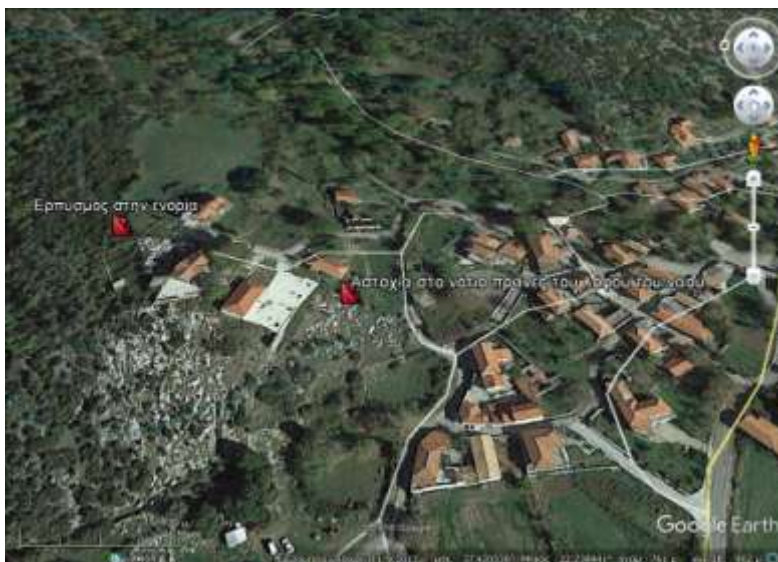
Εικόνα 6.7. Άποψη από τη θέση αστοχίας στον οικισμό Κεραστάρη (Google Earth).
