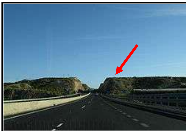
Εικόνα 3.4. Άποψη από χαρακτηριστικό αμφίπλευρο όρυγμα κατά μήκος του αυτοκινητόδρομου A-7 στα νότιο τμήμα της πόλης Βαλένθια (Ισπανία), (από www.geoengineer.org ).
