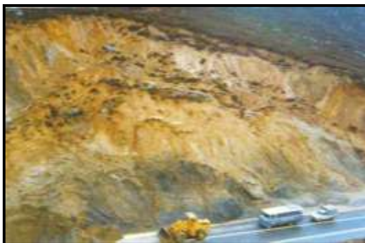
Εικόνα 1.2. Περιτροφική ολίσθηση στη ζώνη αποσάθρωσης της αργιλικής φάσης του φλύσχη στην Εθνική Οδό Λειβαδιάς – Αράχωβας στα τέλη της δεκαετίας του 1970 (Κούκης και Σαμπατακάκης, 2007).
