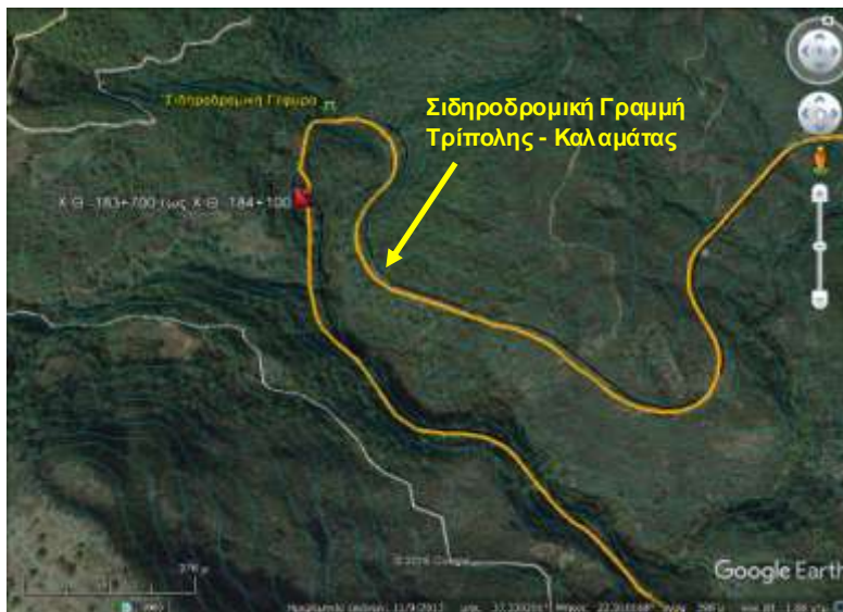
Εικόνα 6.9. Άποψη από τη θέση αστοχίας στο 184 ο χλμ της σιδηροδρομικής γραμμής Τρίπολης – Καλαμάτας (Google Earth).
