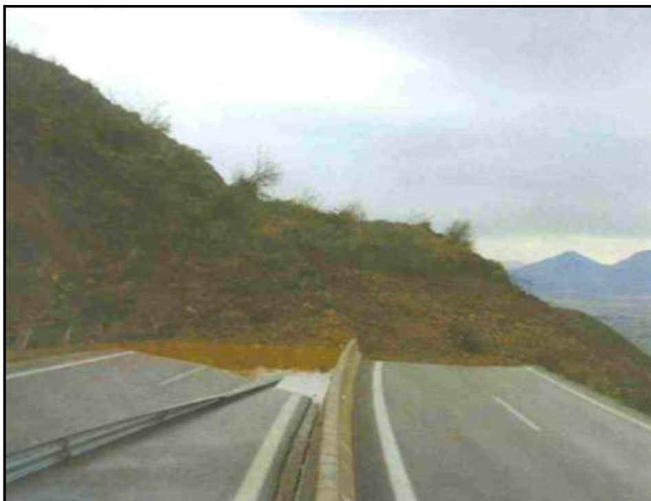
Εικόνα 1.7. Το Φεβρουάριο του 2003 πραγματοποιήθηκε ροή εδαφικών υλικών στη Νέα Εθνική Οδό Τρίπολης – Καλαμάτας, στη θέση Τσακώνα (Κούκης και Σαμπατακάκης, 2007).
