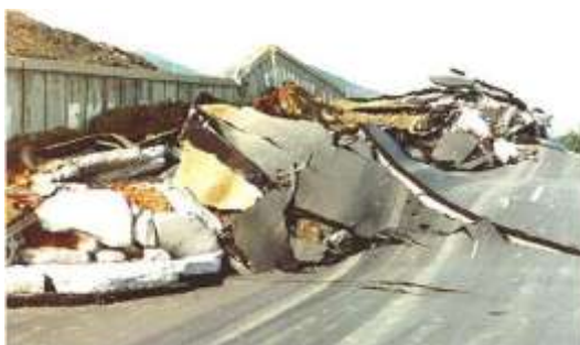
Εικόνα 5.5. Η καταστροφή του οδοστρώματος της Ε.Ο. Αθηνών – Θεσσαλονίκης στη Χ.Θ. 36+000 (Ρόζος κ.α., 1995).
