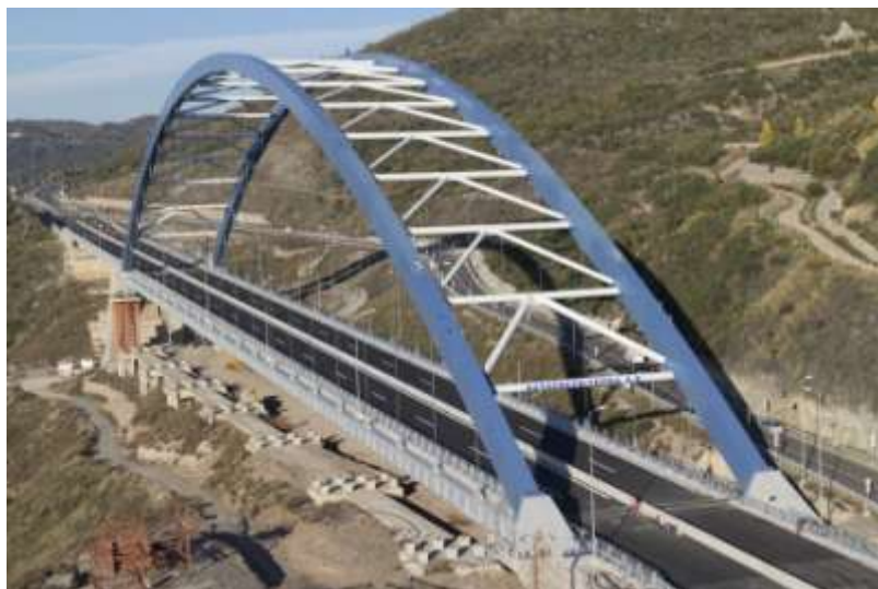
Εικόνα 5.13. Άποψη από την τελική κατασκευαστική λύση της σύμμεικτης τοξωτής γέφυρας (ΥΠΟΜΕΔΙ, 2016).
