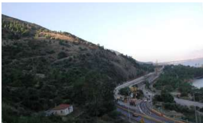
Εικόνα 5.2. Γενική άποψη της θέσης αστοχίας στην Παναγοπούλα από το Ανατολικό άκρο της περιοχής (Υ.ΠΕ.ΧΩ.ΔΕ., 2002).
