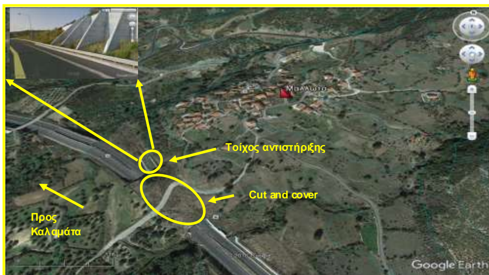
Εικόνα 6.18. Άποψη από τη δυνητική θέση αστοχίας στον οικισμό Μαλλωτά. Διακρίνονται δύο χαρακτηριστικά τεχνικά έργα για την αντιμετώπιση τυχόν ολίσθησης. Το cut and cover και ο τοίχος αντιστήριξης (Google Earth).
