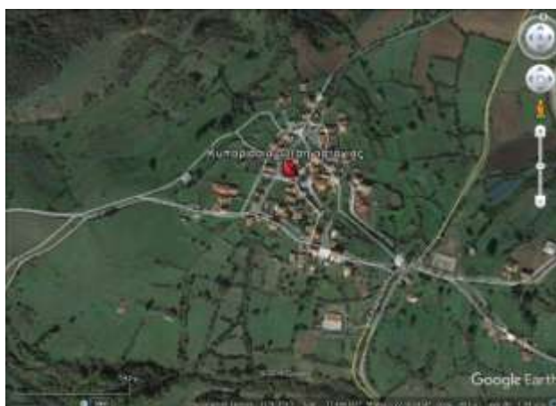
Εικόνα 6.13. Άποψη από τη θέση αστοχίας στον οικισμό Κυπαρίσσια (Google Earth).
