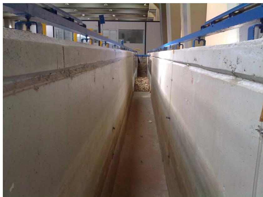
Εικόνα 5.2 Άποψη του εσωτερικού της διάρυνας βαρύτητας του εργαστηρίου λιμενικών έργων
