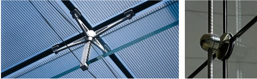
Εικόνα 4.6. Συστήματα σημειακής πάκτωσης
