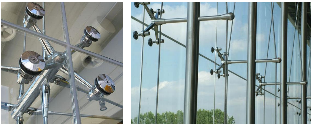
Εικόνα 4.5. Σύστημα σημειακής στήριξης με εξαρτήματα τύπου "spider"
