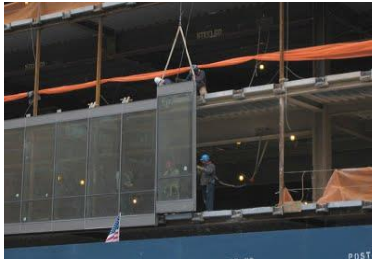
Εικόνα 4.2. Σύστημα δομικού υαλοπετάσματος
