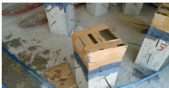
Σχήμα 3.4: Διαδικασία χύτευσης αυτοεπιπεδούμενης τσιμεντοκονίας υψηλής αντοχής στην άνω στάθμη σκυροδέτησης των υποστυλωμάτων
