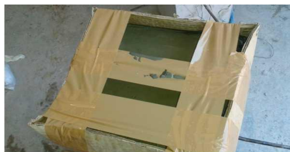
Σχήμα 3.4: Διαδικασία χύτευσης αυτοεπιπεδούμενης τσιμεντοκονίας υψηλής αντοχής στην άνω στάθμη σκυροδέτησης των υποστυλωμάτων
