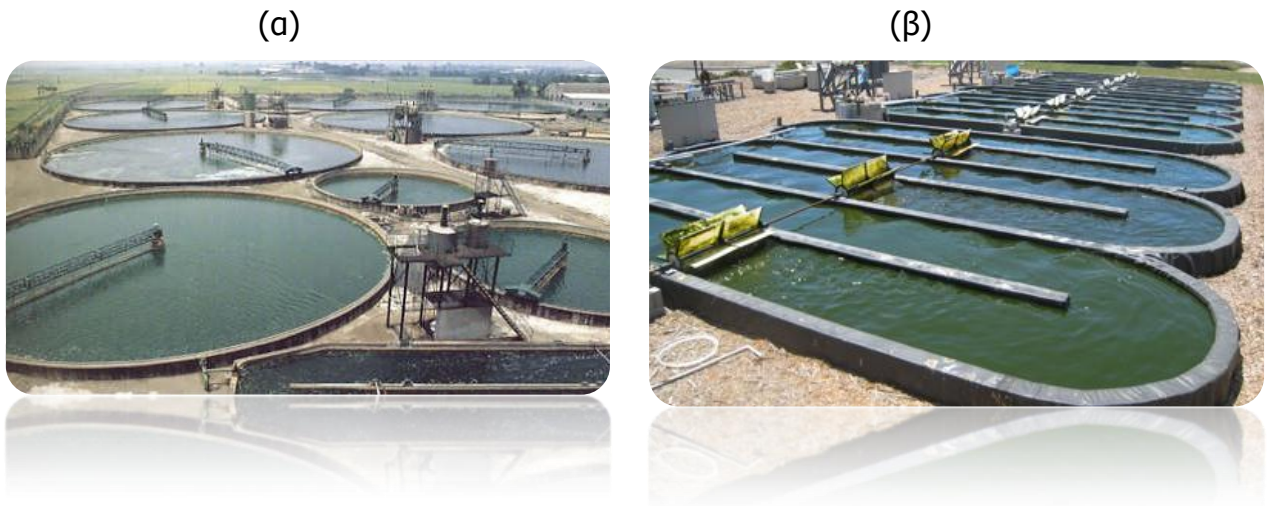
Εικόνα 1.5: Κυκλική δεξαμενή ανοιχτού τύπου (α) , raceway open ponds (β)
