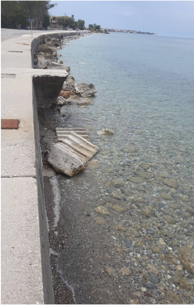
Σχήμα 3.18. Πτώση κλίμακας εντός οικισμού Μελισσίου
