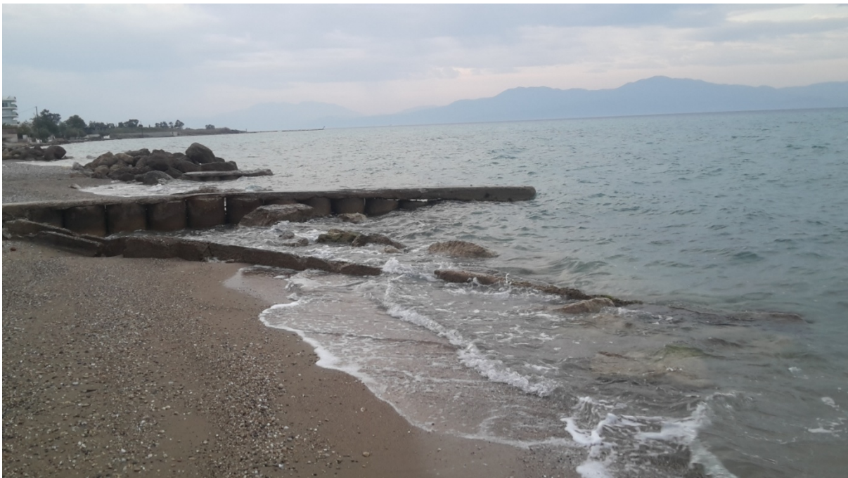
Σχήμα 3.12. Τμήμα προβόλου με βλάβες καθώς και προσθήκη θωράκισης με λειτουργία προβόλου στην παραλία της Νεράτζας
