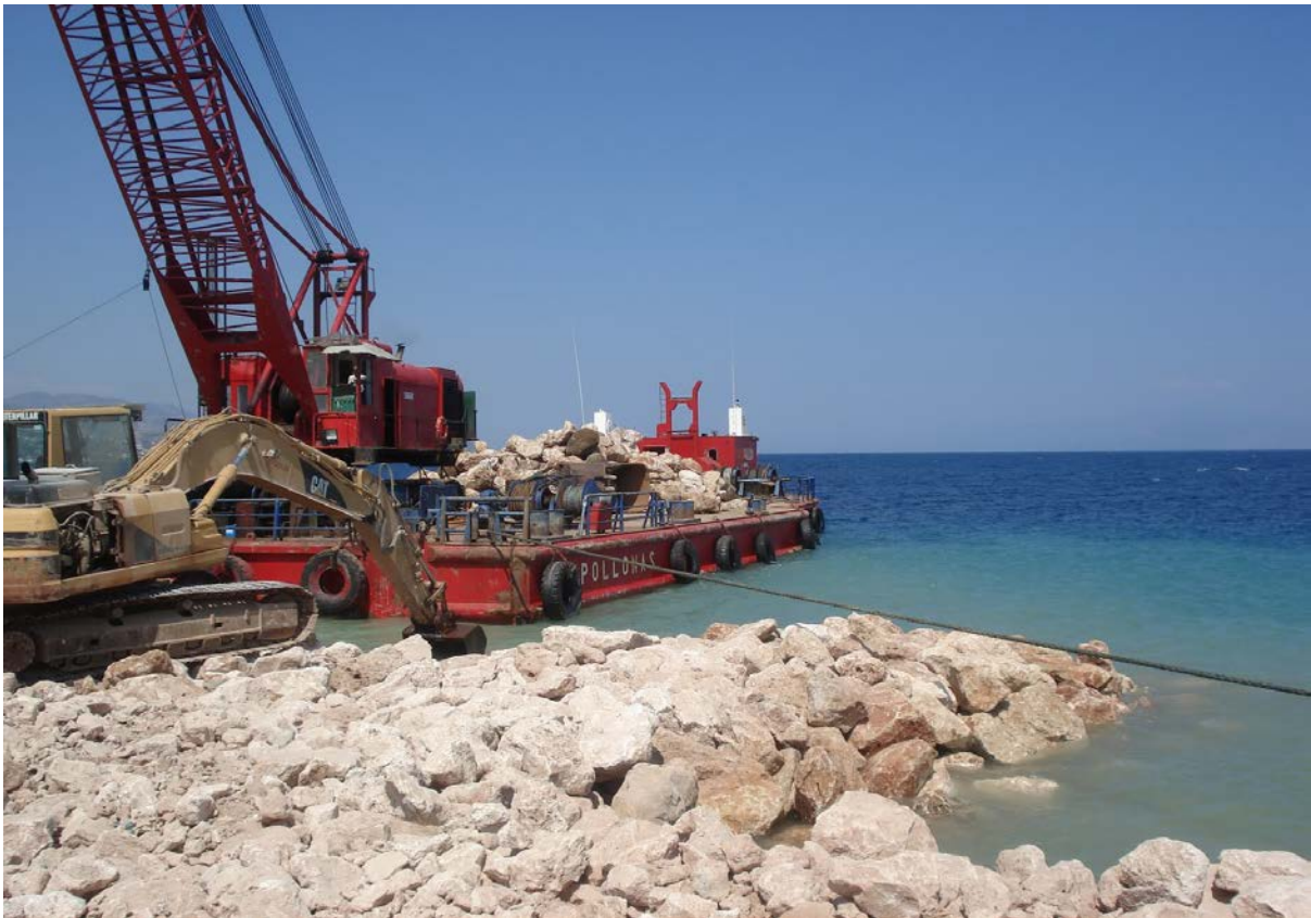
Σχήμα 4.2. Φωτογραφία από τη φάση κατασκευής του έργου. Βυθοκόρος φέρνει τους ογκόλιθους για την θωράκιση των κυματοθραυστών. Πηγή: (Dr. Απόστολος Παπαφωτίου)
