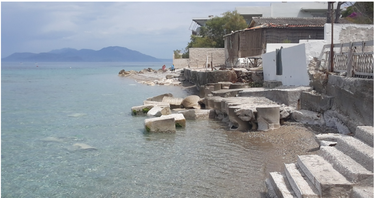
Σχήμα 3.19. Υποσκαφή σε οικίες στο Μελίσι.
