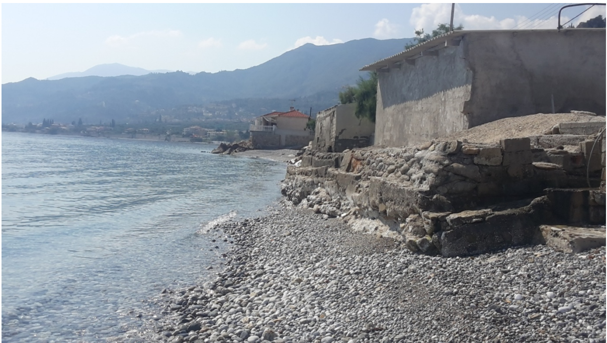
Σχήμα 3.25. Οικίες χωρίς θωράκιση εκτεθειμένες στην κυματική δράση
