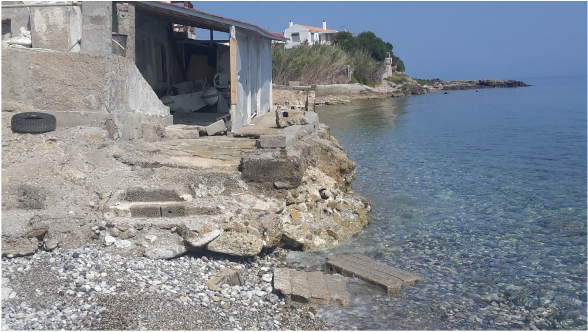
Σχήμα 3.26. Οικίες χωρίς θωράκιση εκτεθειμένες στην κυματική δράση
