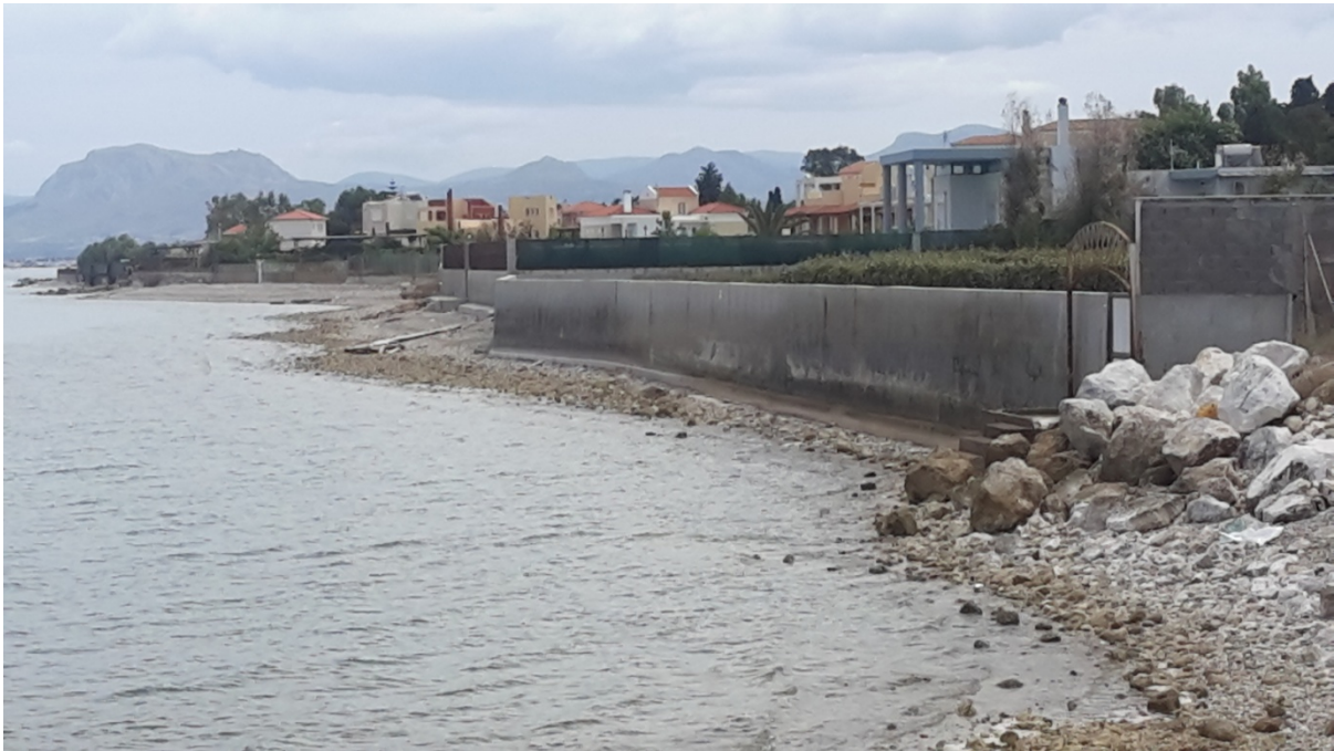
Σχήμα 3.16. Εξωτερικά τοιχία περίφραξης κατοικιών
