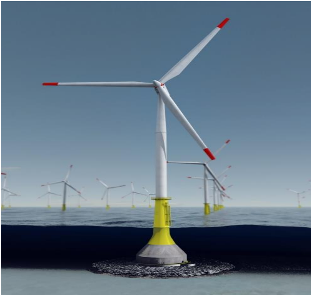
Σχήμα 5: Ανεμογεννήτρια που η δομή της στηρίζεται στη βαρύτητα.
