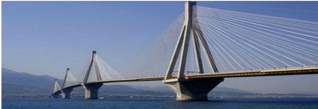
Σχήμα 24: Καλωδιωτή γέφυρα σε σχεδιασμό βεντάλιας.
