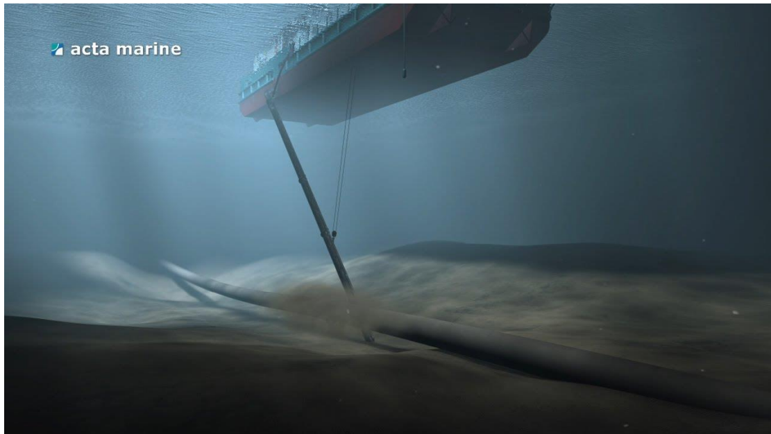
Σχήμα 21: Προσομοίωση Τοποθέτησης Υποβρύχιου Αγωγού.
