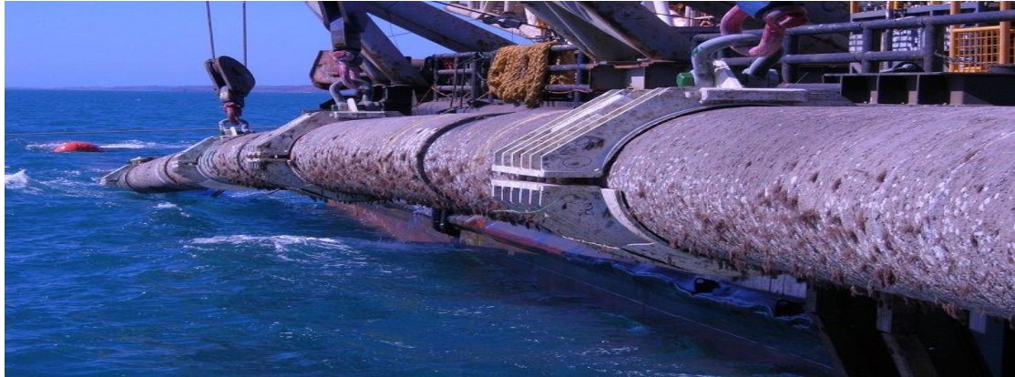
Σχήμα 20: Τοποθέτηση Υποβρύχιου Αγωγού.
